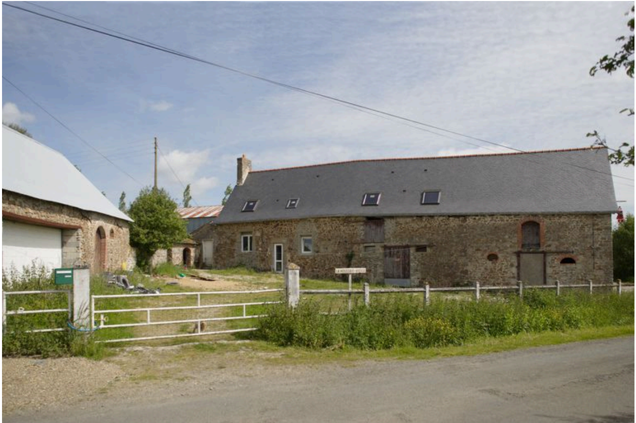
Le logis-étable vu depuis la route de Sainte-Suzanne au sud-ouest.
