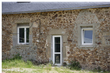
La façade du logis. Phot. François Lasa IVR52_20055301560NUCA
