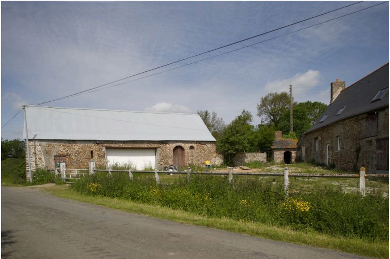
L'étable-grange vue depuis la route de Sainte-Suzanne au sud-est.
