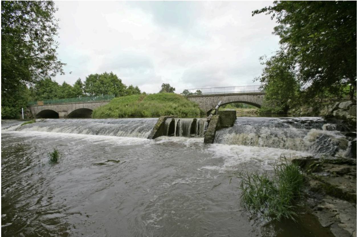
Vue d'aval, depuis la rive gauche.
