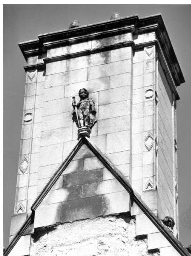
Corps de logis gauche, pignon gauche, souche de cheminée : figure d'enfant portant une épée et un blason aux armes de Pincé.
