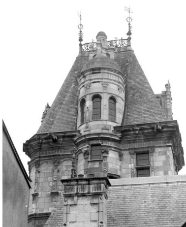
Corps d'escalier, élévation latérale droite, partie haute.
