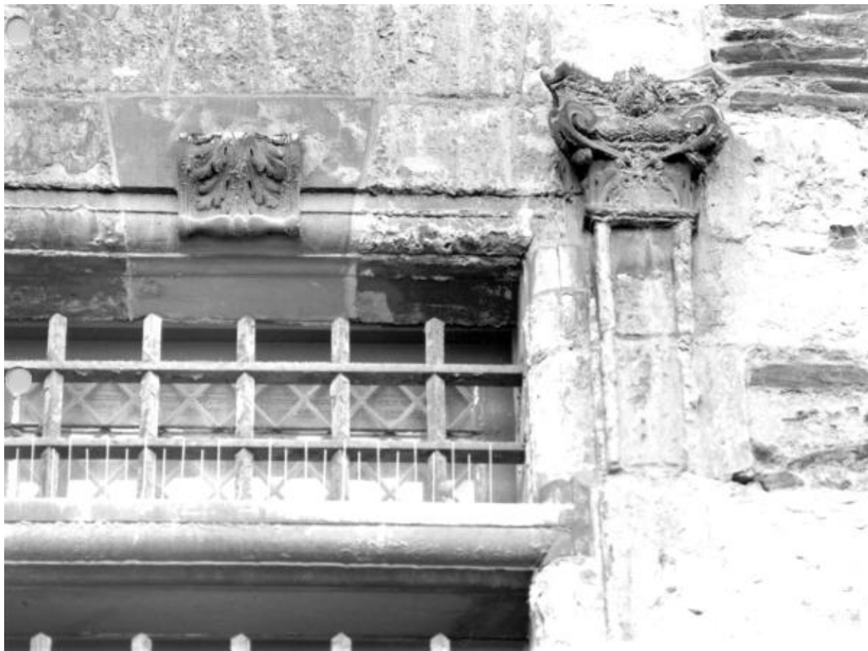
Corps de logis gauche (sud), élévation postérieure, baie gauche du 2e niveau : partie supérieure droite de la plate-bande.
