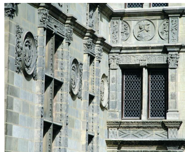
Détail : travées du logis gauche et de l'escalier, rez-de-chaussée. Phot. Patrice Giraud IVR52_19874900873XA
