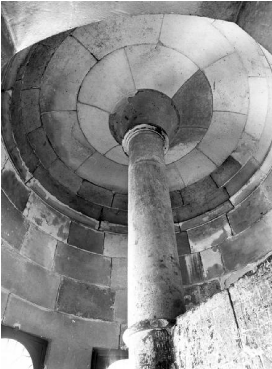
Corps d'escalier, voûte de l'escalier d'accès à la chambre haute.
