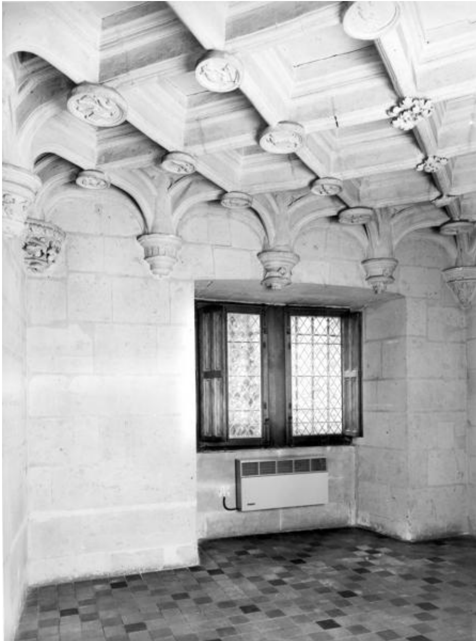
Corps d'escalier, cabinet du 2e niveau : vue d'ensemble depuis l'entrée.
