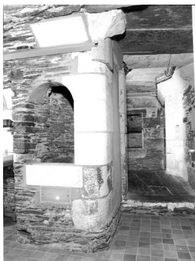
Etage de soubassement, pièce située sous le vestibule, mur antérieur : puits et accès à la cage d'escalier. Phot. François Lasa IVR52_19934900043X
