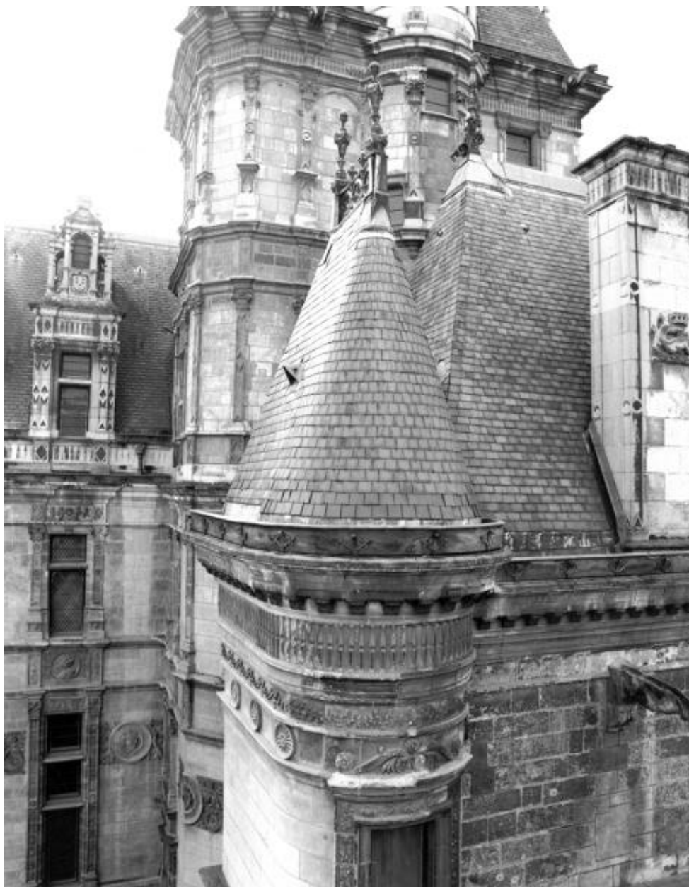
Logis, parties hautes vues depuis la rue de l'Espine. Au 1er plan, entablement de la tourelle sur trompe.
