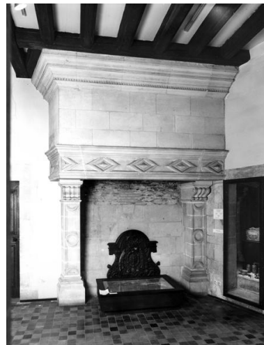
Corps de logis droit, rez-de-chaussée, pièce postérieure, mur postérieur : cheminée. Phot. François Lasa IVR52_19914901114V
