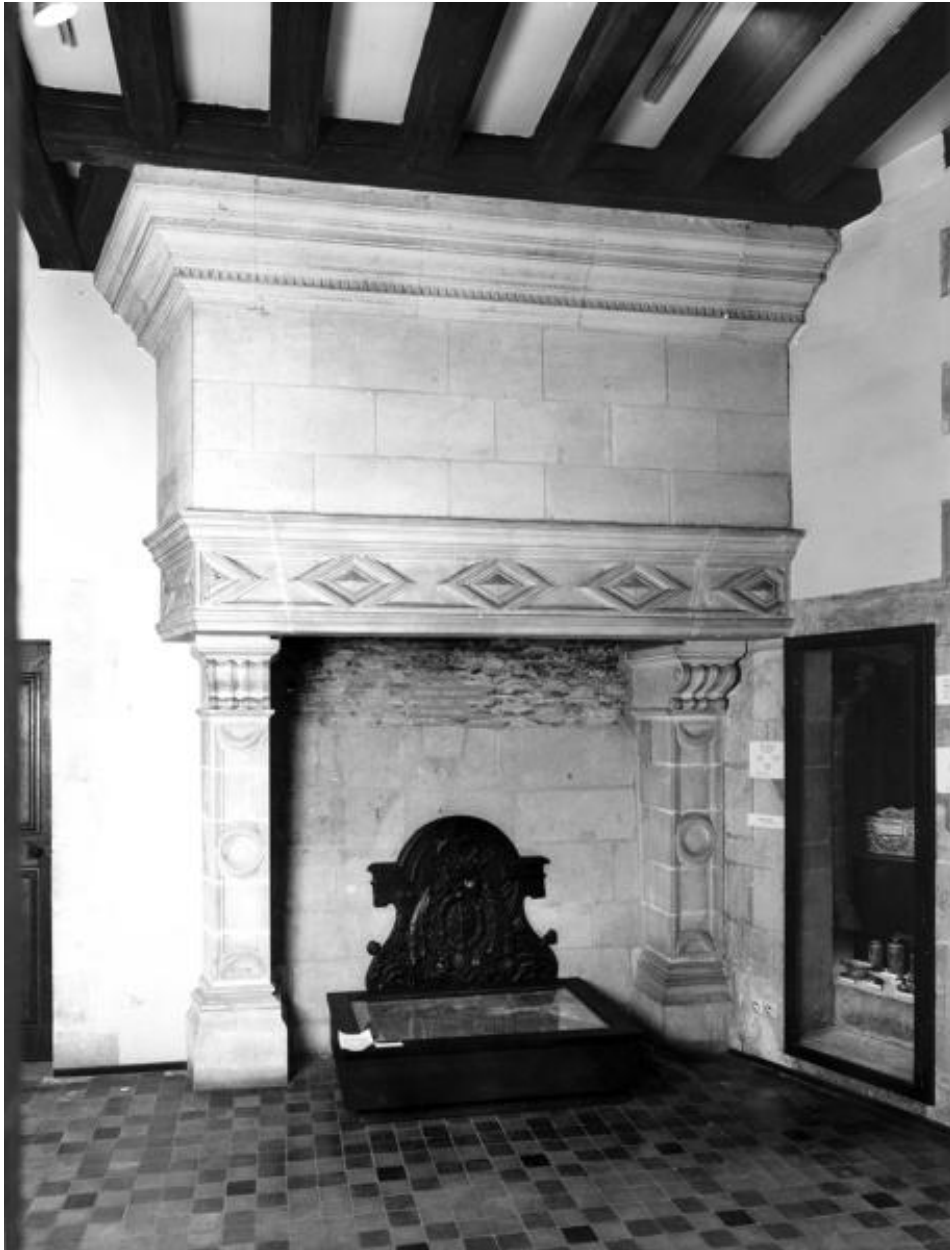
Corps de logis droit, rez-de-chaussée, pièce postérieure, mur postérieur : cheminée.
