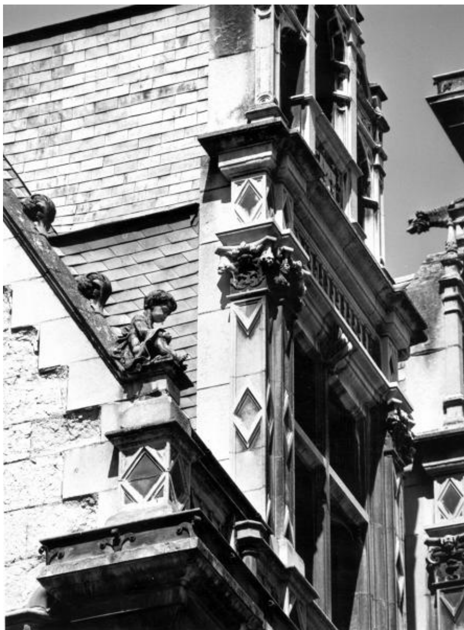
Corps de logis gauche, élévation antérieure, crossette du pignon : enfant et lucarne de gauche en vue latérale.
