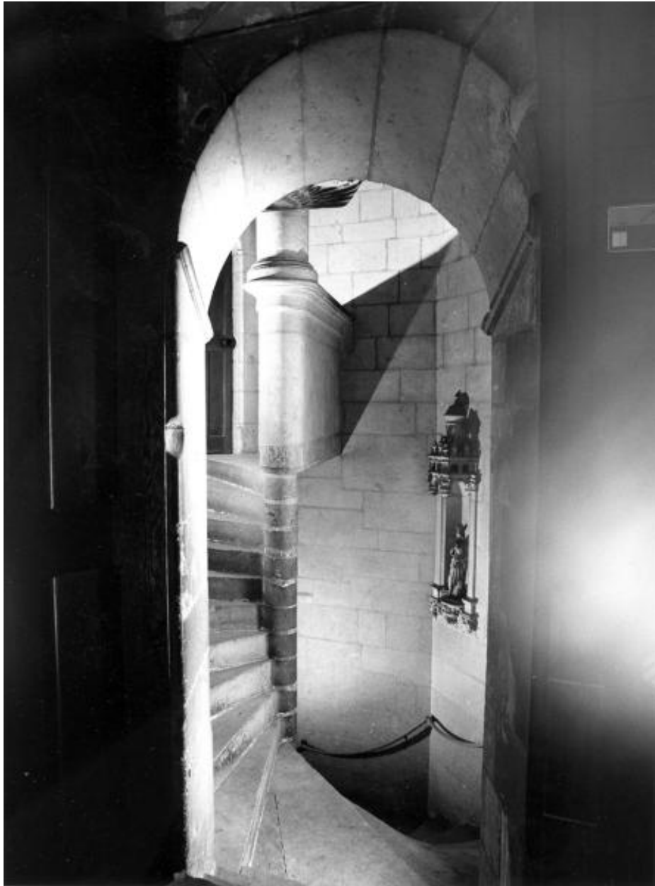
Cage de l'escalier, partie haute de la troisième révolution.
