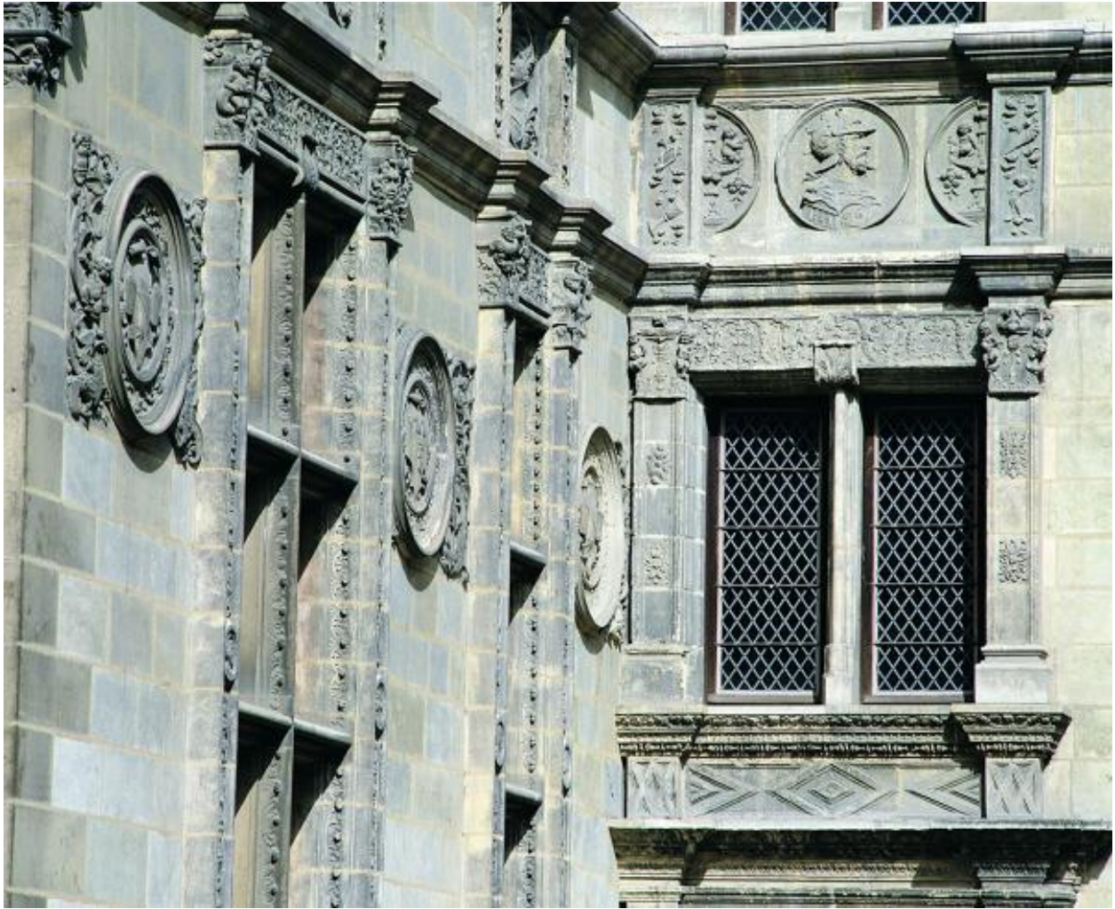
Détail : travées du logis gauche et de l'escalier, rez-de-chaussée.
