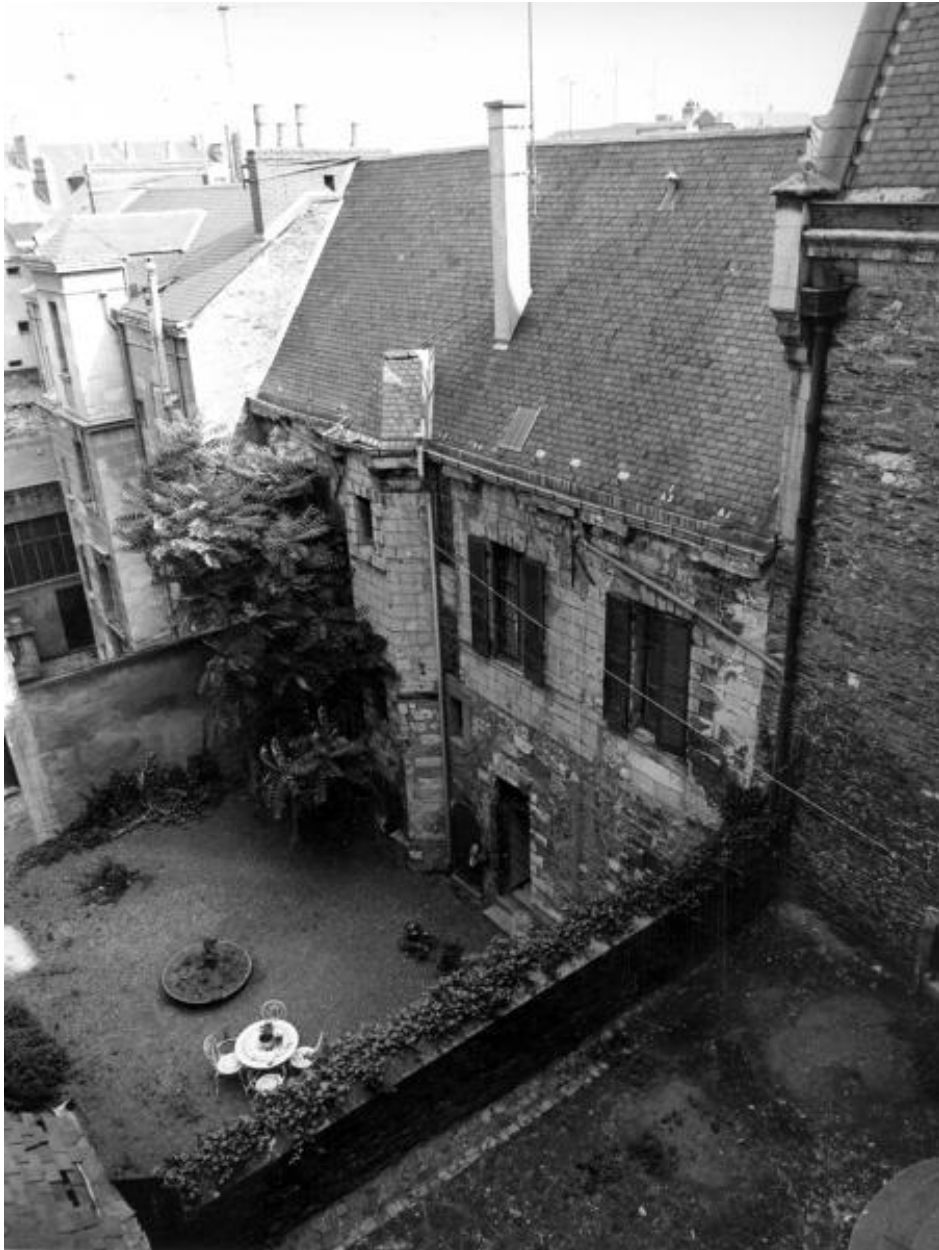
Elévation postérieure, trois-quarts de droite, depuis le sud-est (logis Pincé).
