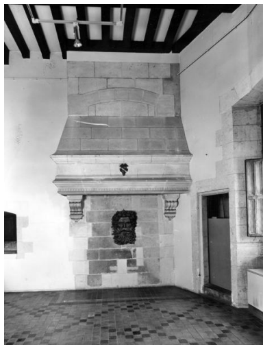
Corps de logis droit, 1er étage, mur postérieur : cheminée. Phot. François Lasa IVR52_19914901110V
