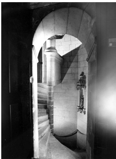
Cage de l'escalier, partie haute de la troisième révolution. Phot. François Lasa IVR52_19914901137X
