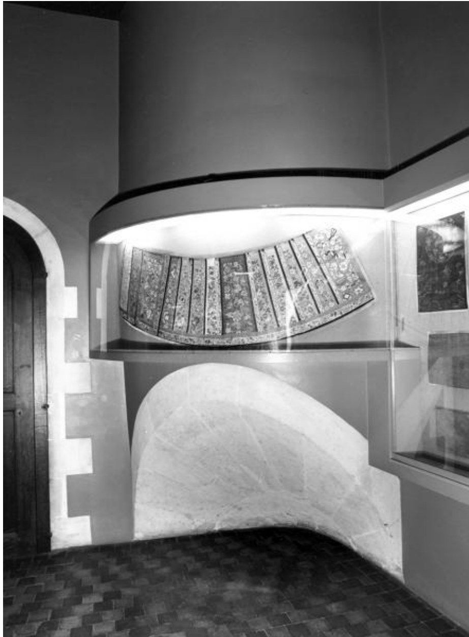
Corps d'escalier, cabinet du 3e niveau, angle antérieur droit : trompe et volume de l'escalier d'accès à la chambre haute.
