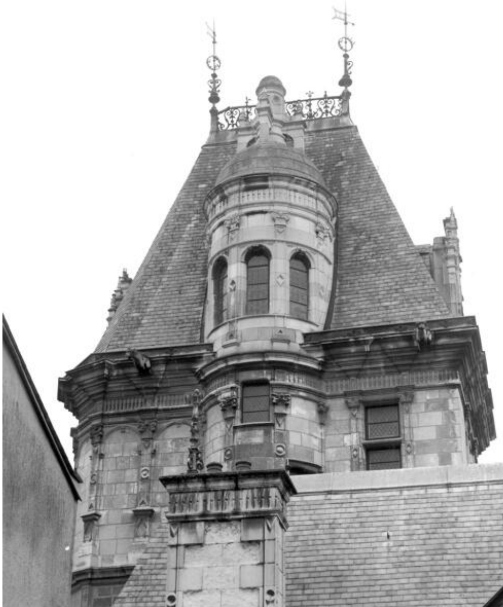
Corps d'escalier, élévation latérale droite, partie haute.
