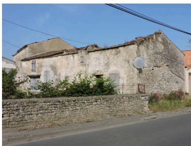
Le logis vu depuis l'est. Phot. Yannis Suire IVR52_20198502482NUCA
