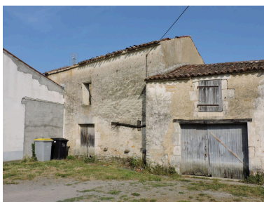
Dépendances dans le prolongement du logis. Phot. Yannis Suire IVR52_20198502484NUCA
