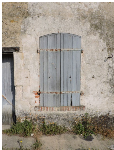
Une des ouvertures, avec linteau en arc segmentaire. Phot. Yannis Suire IVR52_20198502486NUCA
