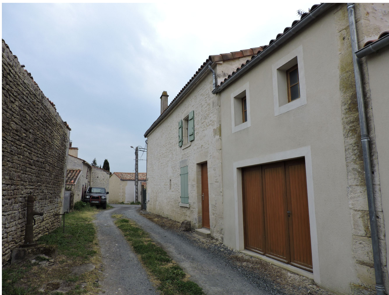
L'ancienne ferme vue depuis le nord-est.
