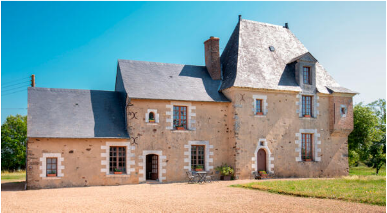
Le corps de logis, élévation principale.
