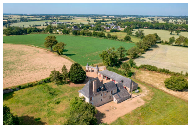
Une vue aérienne de l'Hermitage. Phot. Pierre-Bernard Fourny IVR52_20235300636NUCA
