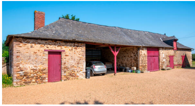
Le corps de dépendances. Phot. Pierre-Bernard Fourny IVR52_20235300758NUCA
