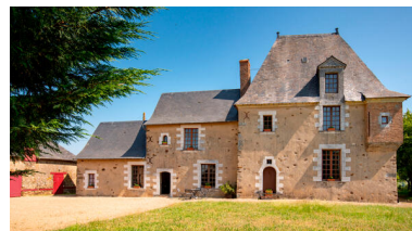
Le corps de logis, élévation principale. Phot. Pierre-Bernard Fourny IVR52_20235300768NUCA
