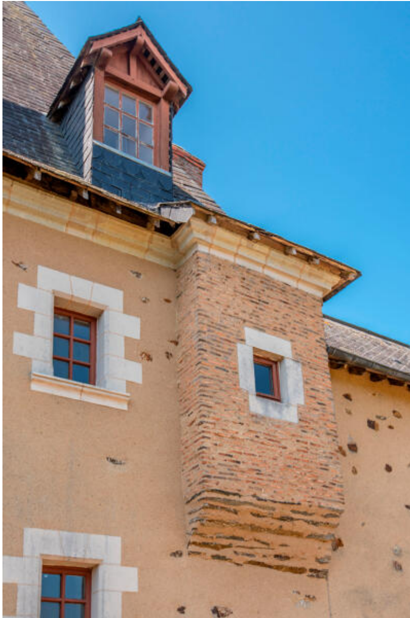
L'échauguette de l'élévation postérieure.
