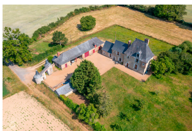
Une vue aérienne de l'Hermitage. Phot. Pierre-Bernard Fourny IVR52_20235300634NUCA
