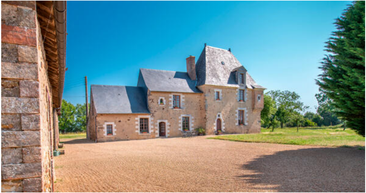
Le corps de logis, élévation principale.
