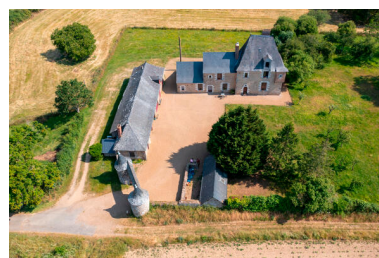
Une vue aérienne de l'Hermitage. Phot. Pierre-Bernard Fourny IVR52_20235300633NUCA
