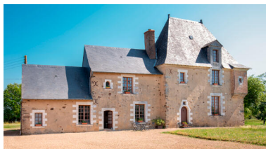
Le corps de logis, élévation principale. Phot. Pierre-Bernard Fourny IVR52_20235300757NUCA
