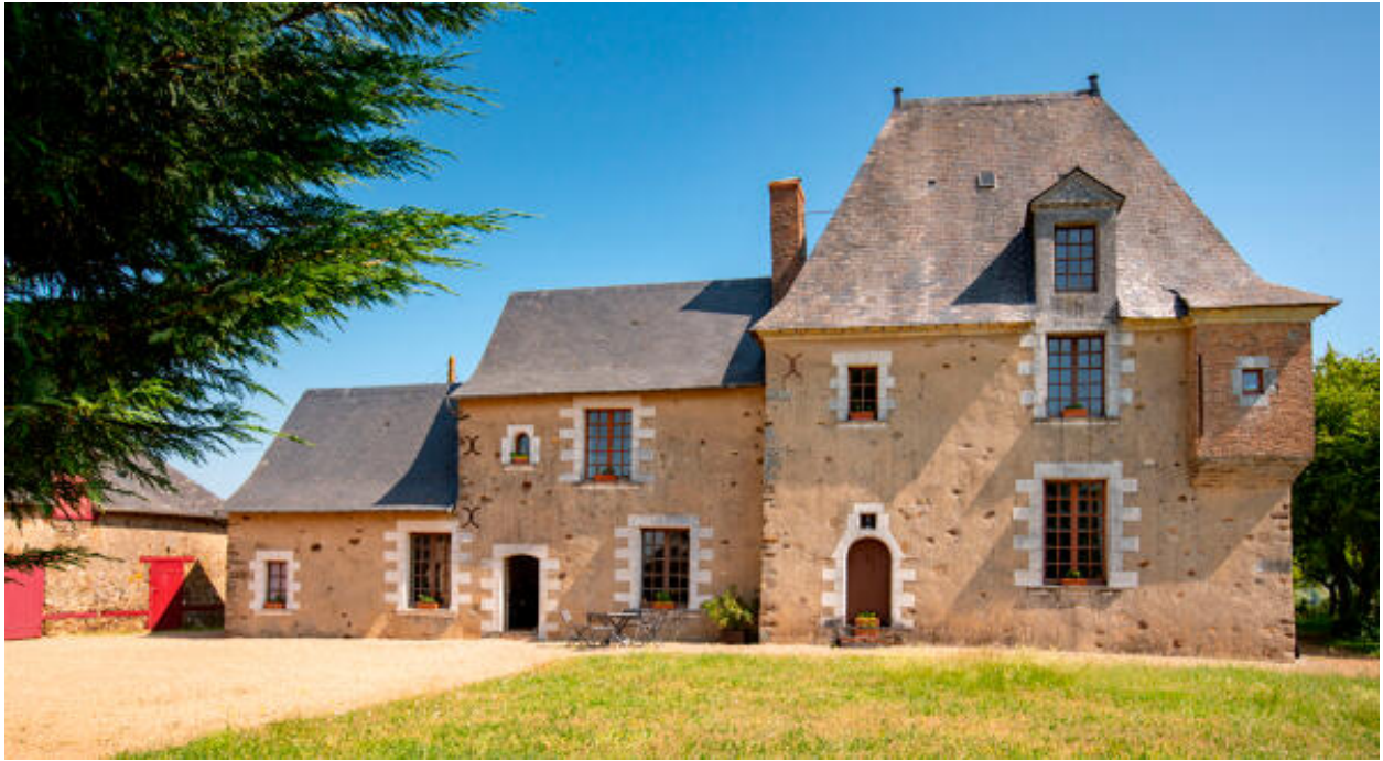
Le corps de logis, élévation principale.
