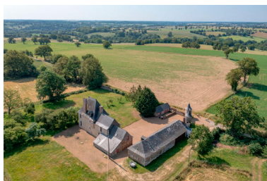
Une vue aérienne de l'Hermitage. Phot. Pierre-Bernard Fourny IVR52_20235300637NUCA
