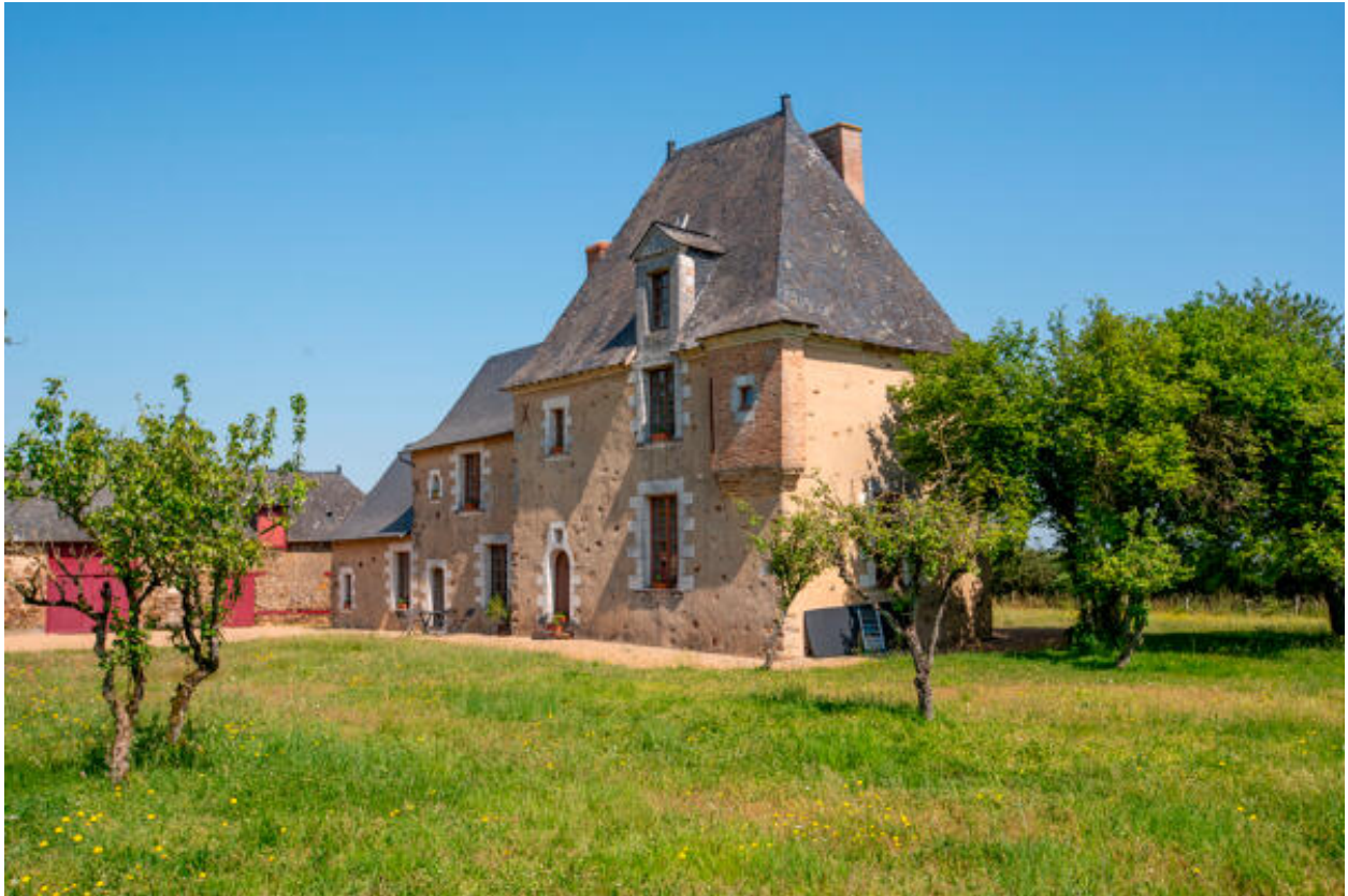
Le corps de logis, élévation principale.
