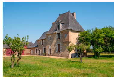
Le corps de logis, élévation principale. Phot. Pierre-Bernard Fourny IVR52_20235300767NUCA
