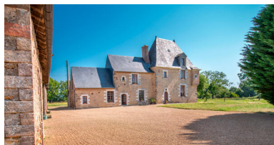
Le corps de logis, élévation principale. Phot. Pierre-Bernard Fourny IVR52_20235300756NUCA
