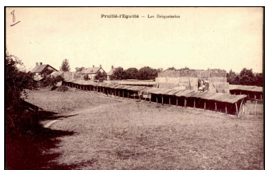
Hangars de séchage des briques, et four à ciel ouvert. IVR52_20127200543NUCA
