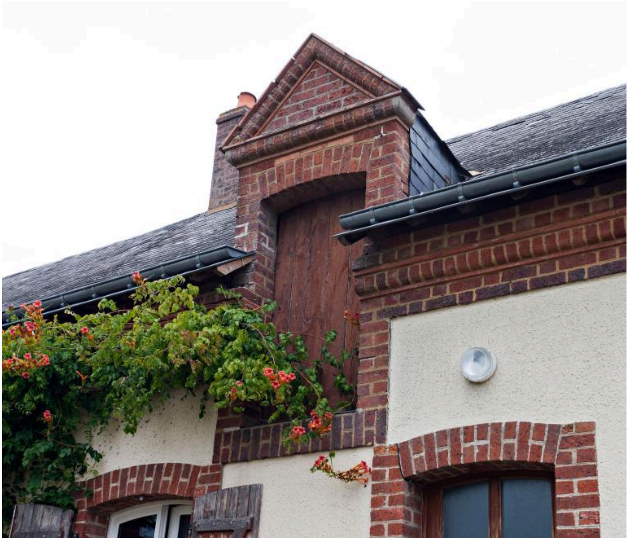
Maison de l'ensemble 1 : détail de la corniche et lucarne passante.
