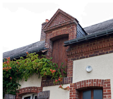
Maison de l'ensemble 1 : détail de la corniche et lucarne passante. Phot. Yves Guillotin IVR52_20117200146NUCA
