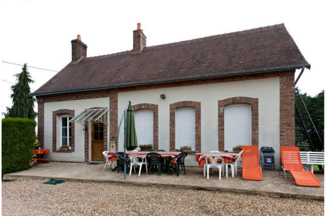
Ensemble 2. Ex-briqueterie Soulard, puis Huger, puis Choquet.
