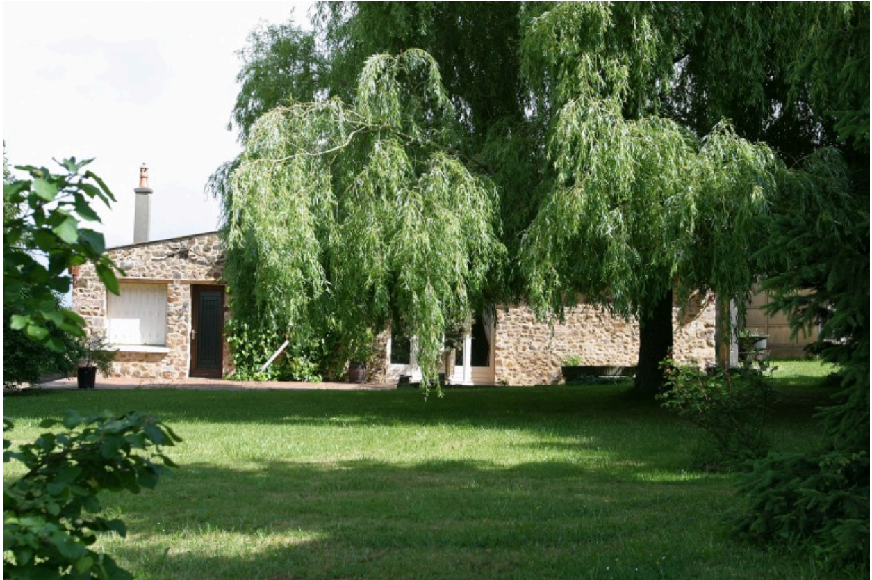
Le logis nord vu depuis le sud.
