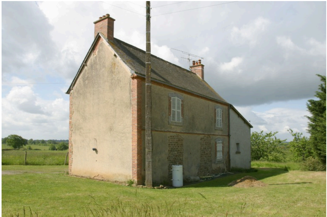
Le logis sud : ancienne façade principale au nord.
