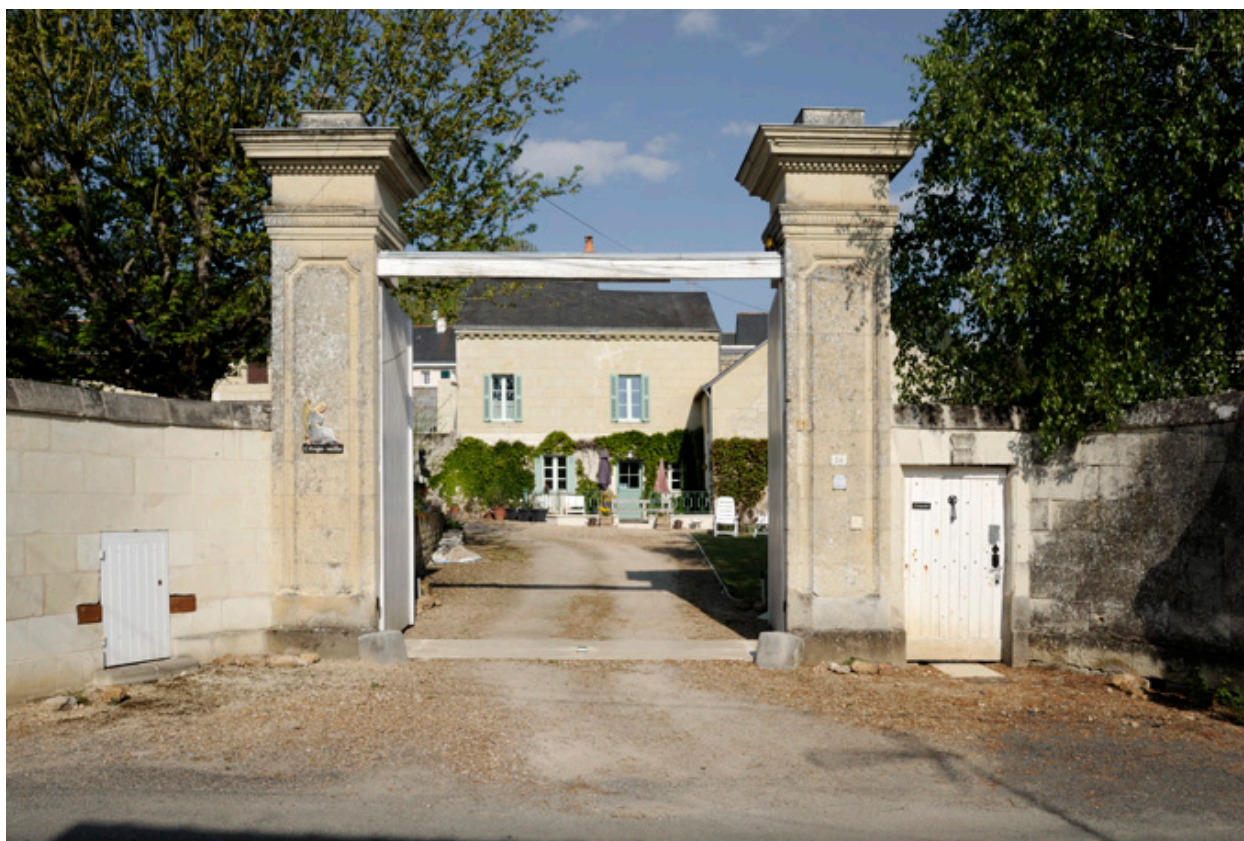
Vue générale : le portail et la ferme en arrière-plan.
