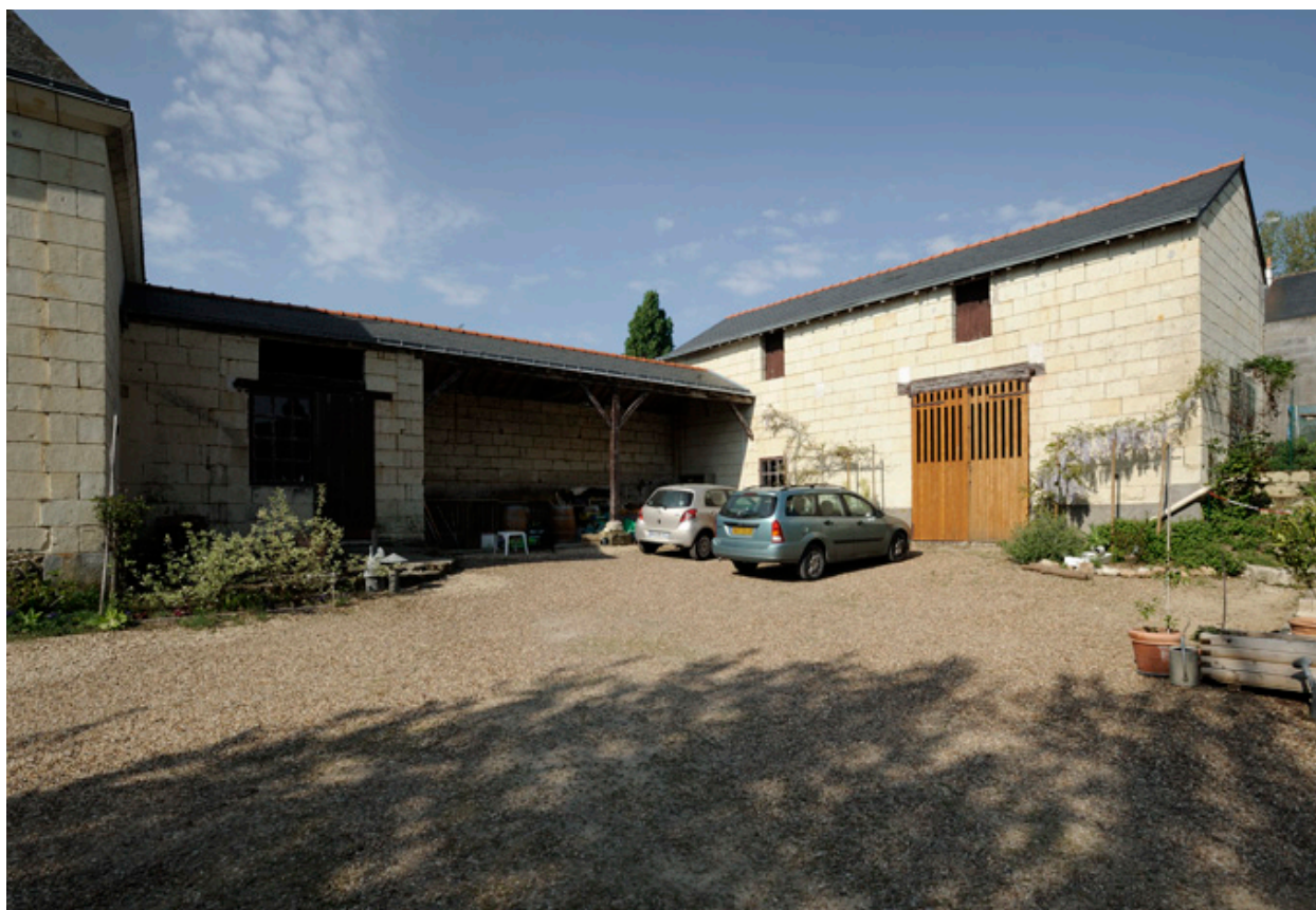
Grange (XIXe siècle) et remise.
