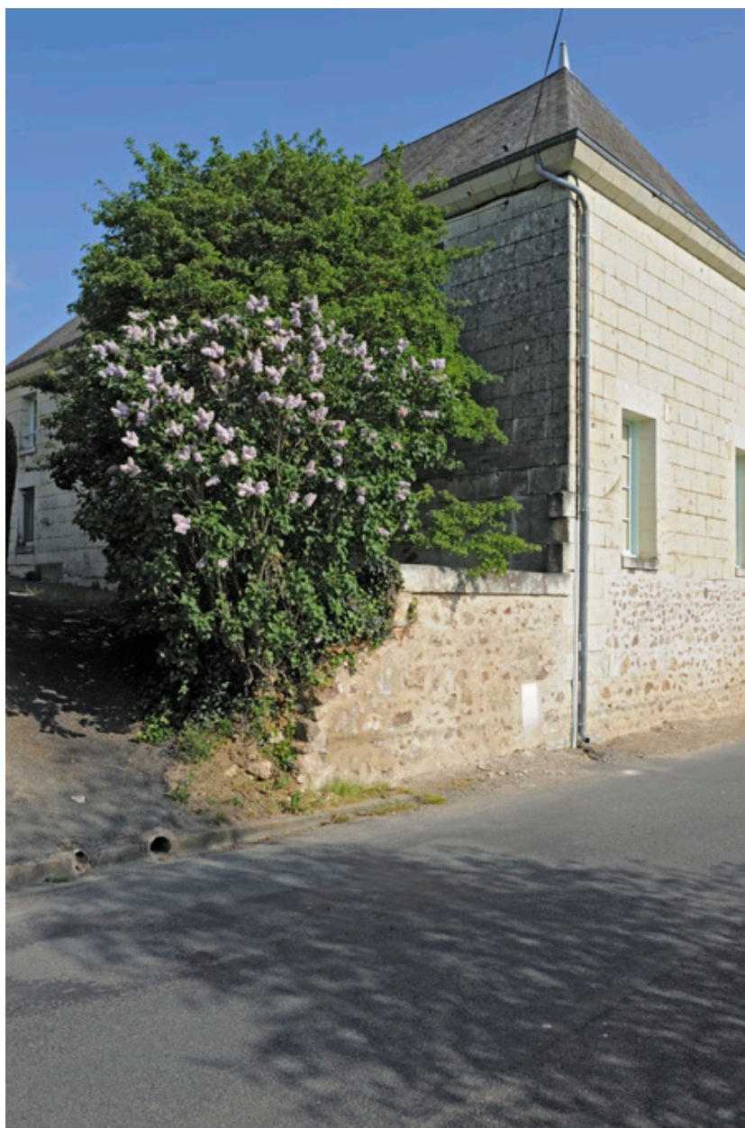
Façade postérieure de la grange (devenue habitation).
