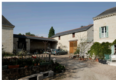
Vue d'ensemble de la grange (XIXe siècle) et la remise. Phot. Bruno Rousseau, Phot. Youenn Communeau IVR52_20114901665NUCA
