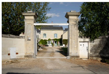
Vue générale : le portail et la ferme en arrière-plan. Phot. Bruno Rousseau, Phot. Youenn Communeau IVR52_20114901666NUCA
