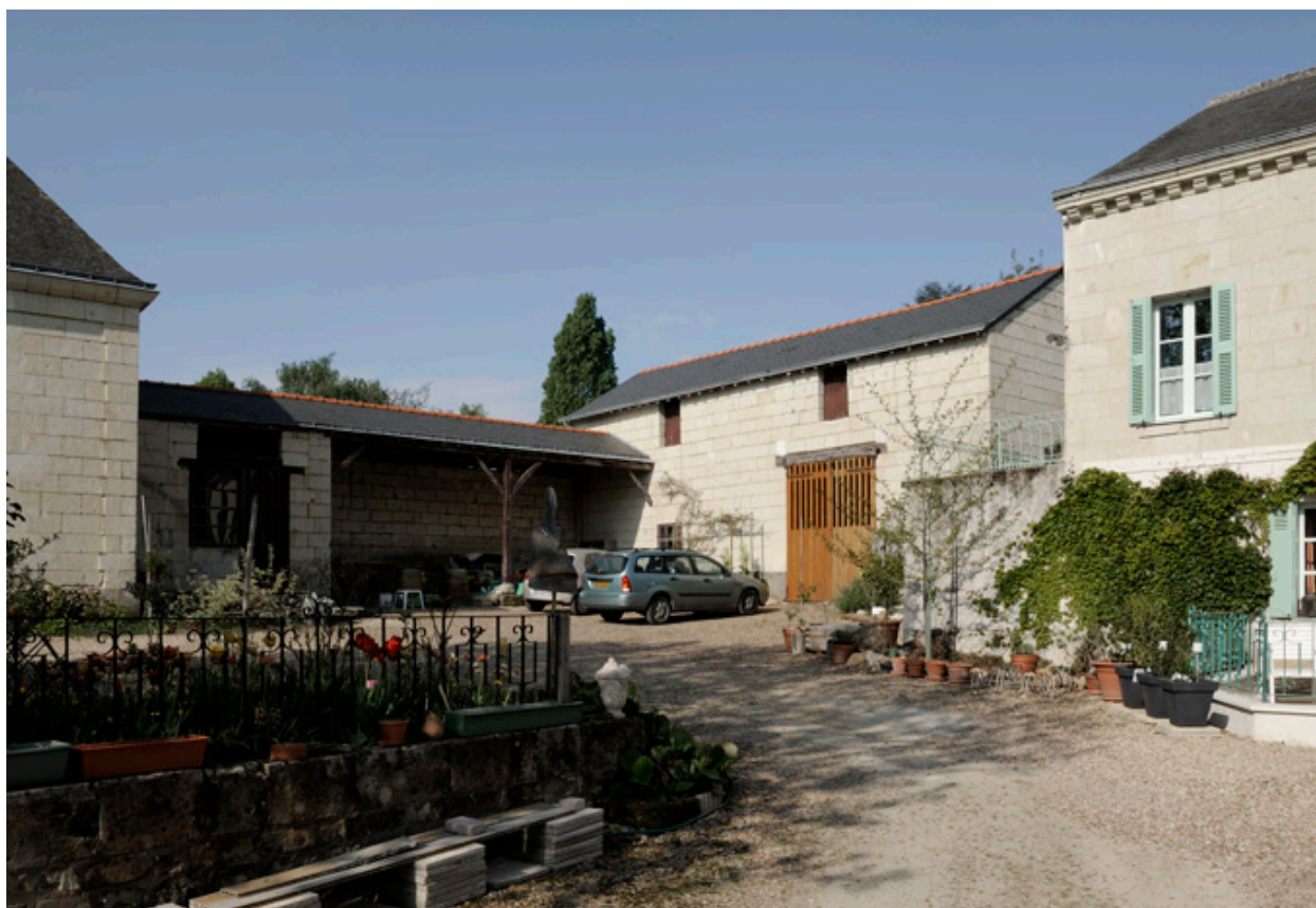
Vue d'ensemble de la grange (XIXe siècle) et la remise.
