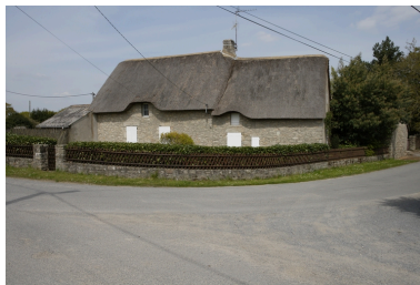
Vue d'ensemble depuis le sud. Phot. Denis Pillet IVR52_20084401487NUCA
