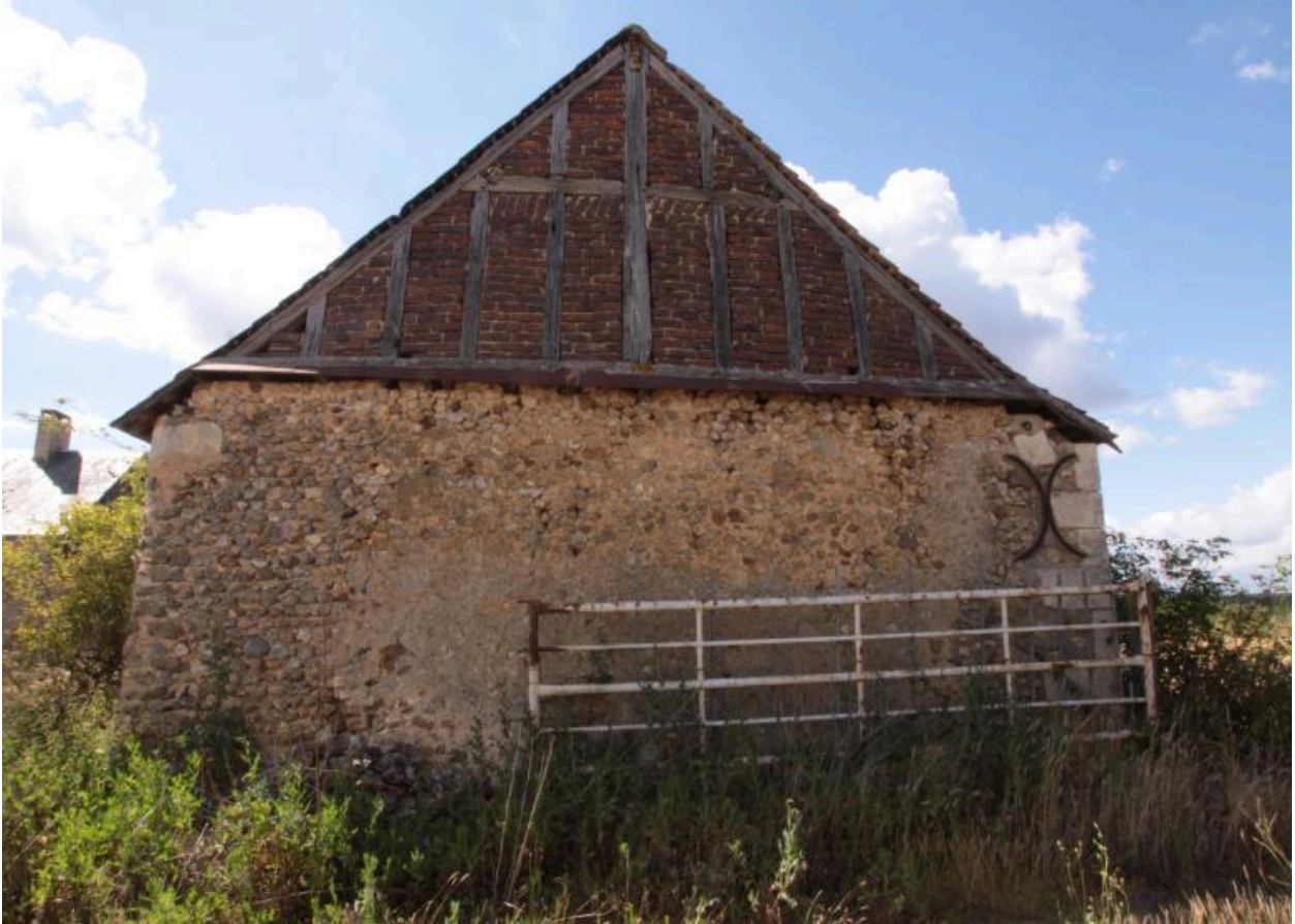
Grange 1 : mur-pignon fermé par des planches.
