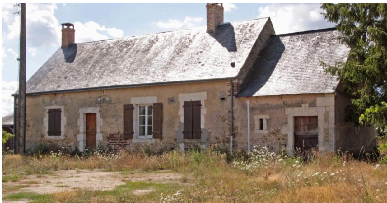
La maison : façade antérieure sur cour.
