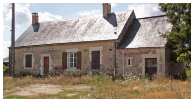
La maison : façade antérieure sur cour. Phot. Jean-Baptiste Darrasse IVR52_20107201555NUCA
