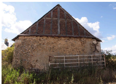
Grange 1 : mur-pignon fermé par des planches. Phot. Jean-Baptiste Darrasse IVR52_20107201554NUCA
