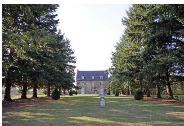
Le manoir de la Vallée vu depuis l'est. Phot. François Lasa IVR52_20055302217NUCA
