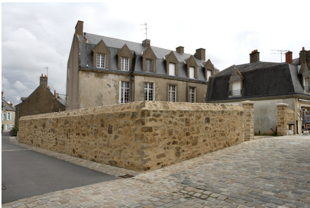
Vue générale vers le Nord-Est.
