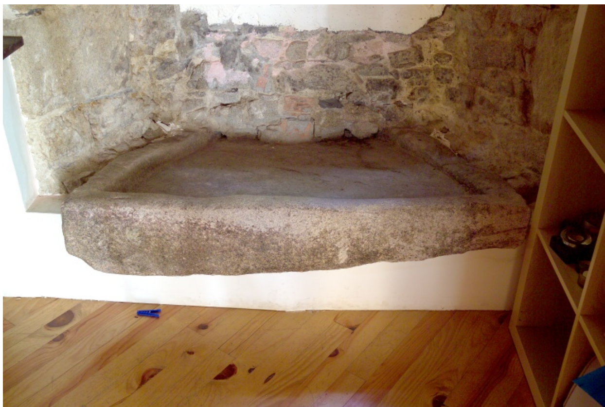
Détail de l'évier de l'appartement est au rez-de-chaussée.
