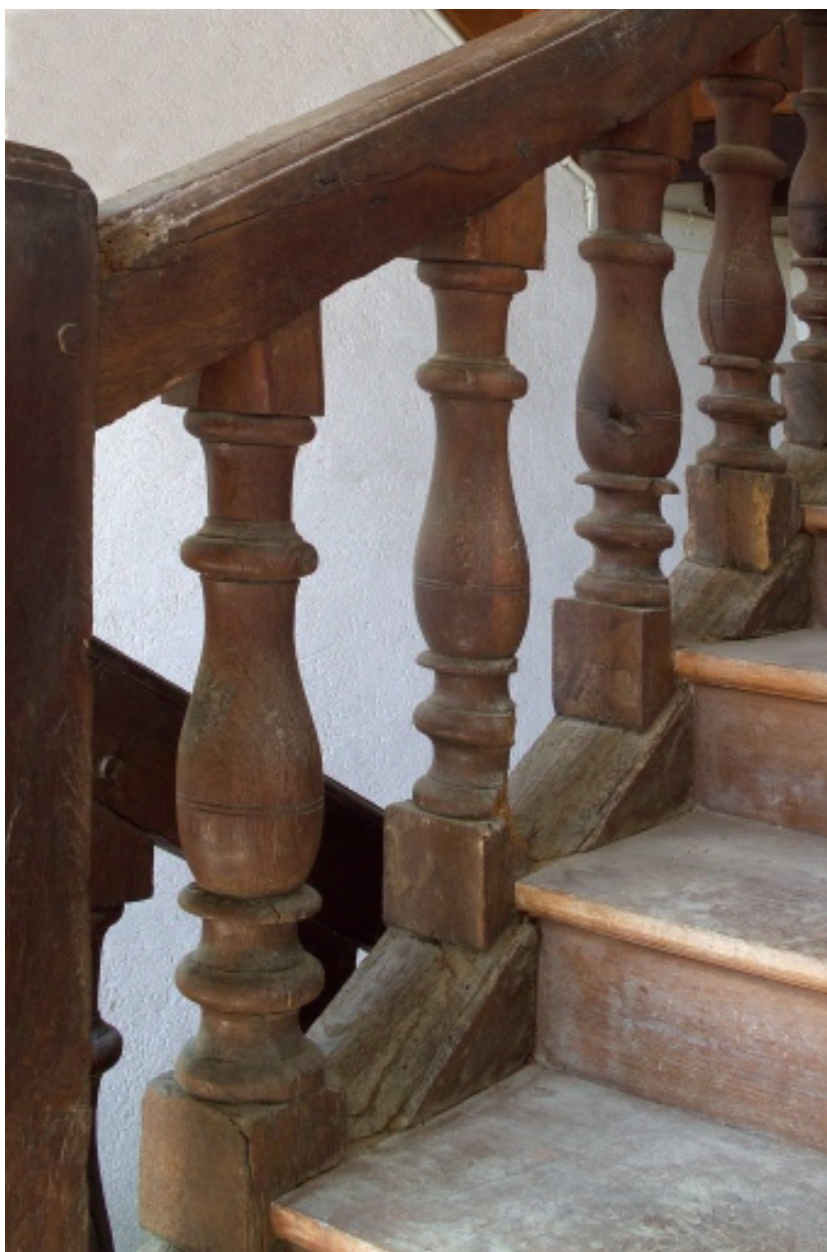
Détail des balustres de l'escalier.
