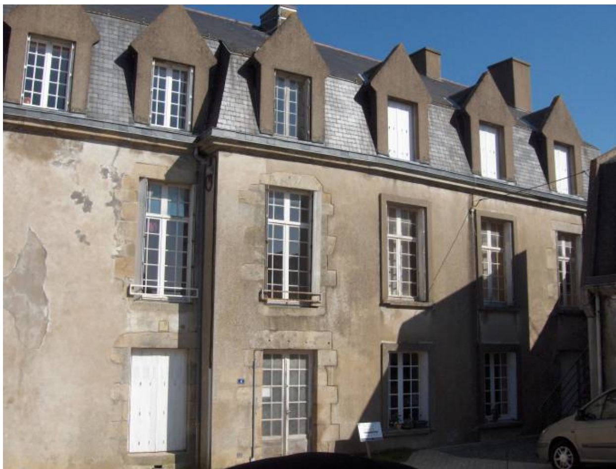
Vue de la façade sud.
