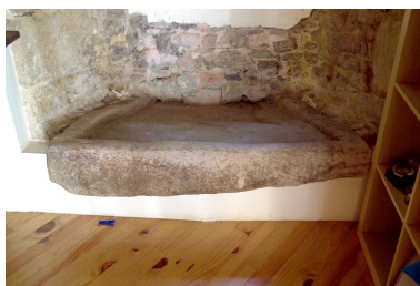
Détail de l'évier de l'appartement est au rez-de-chaussée. Phot. Denis Pillet IVR52_20074400763NUCA
