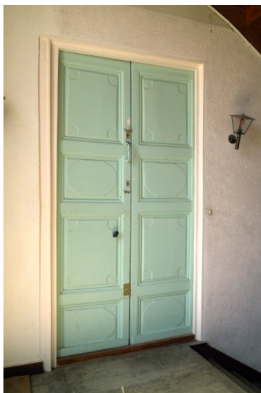
Porte de l'appartement ouest, premier étage. Phot. Denis Pillet IVR52_20074400731NUCA
