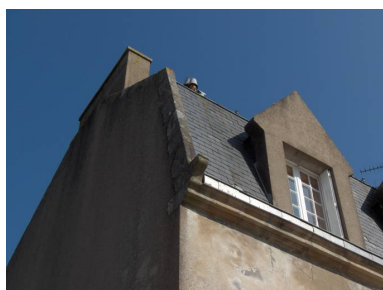
Détail de la toiture à pans brisés sur la façade sud. Phot. Frédéric Dufrêche IVR52_20074405045NUCA
