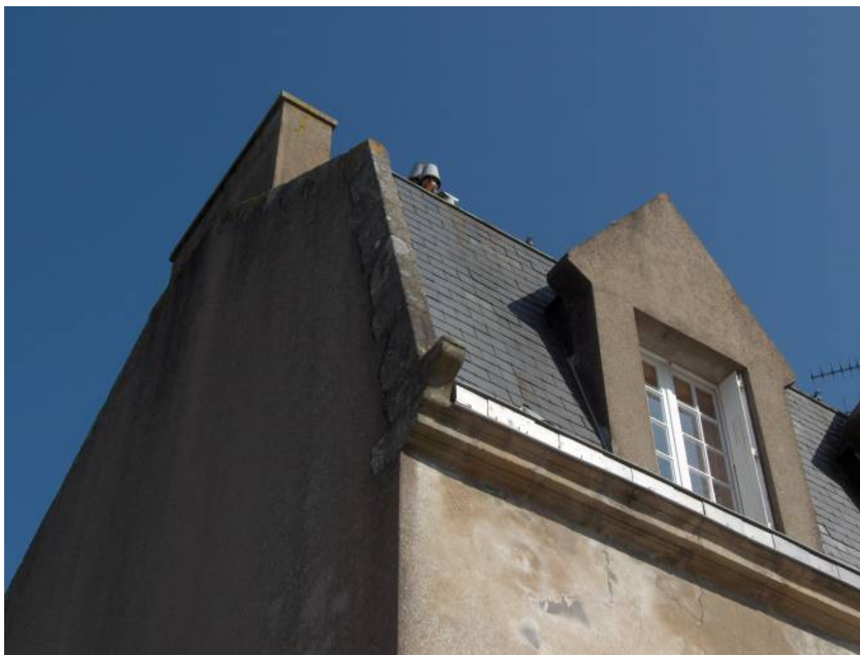
Détail de la toiture à pans brisés sur la façade sud.
