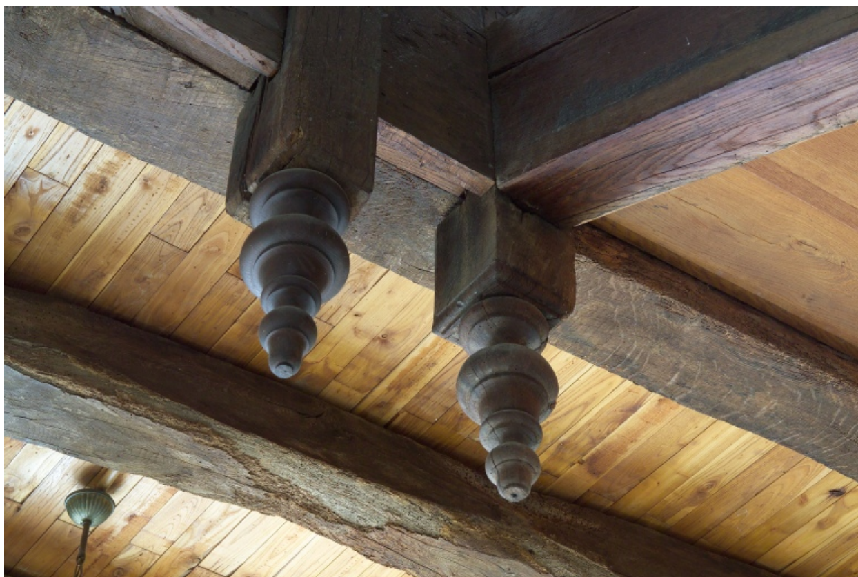
Détail des poinçons pendants de l'escalier.
