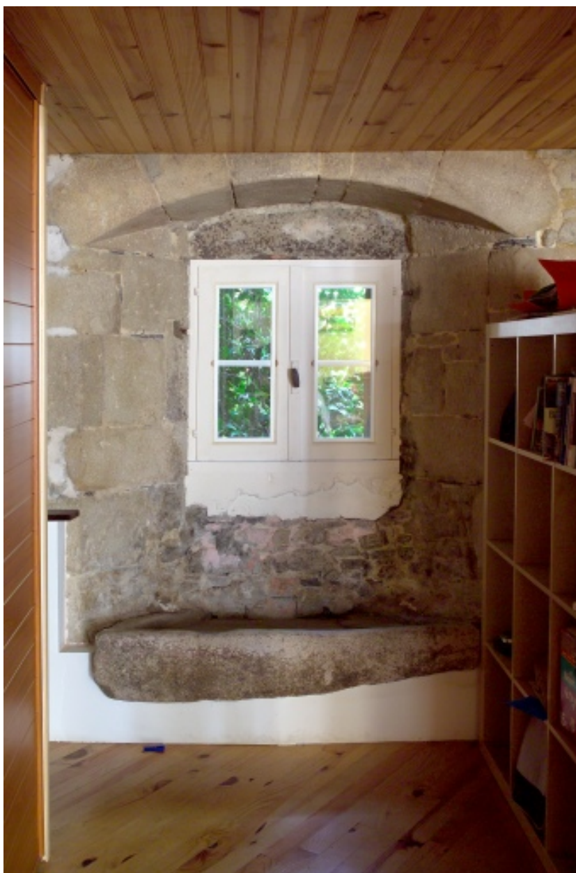
Fenêtre avec évier dans l'appartement est au rez-de-chaussée.
