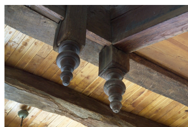
Détail des poinçons pendants de l'escalier. Phot. Denis Pillet IVR52_20074400739NUCA
