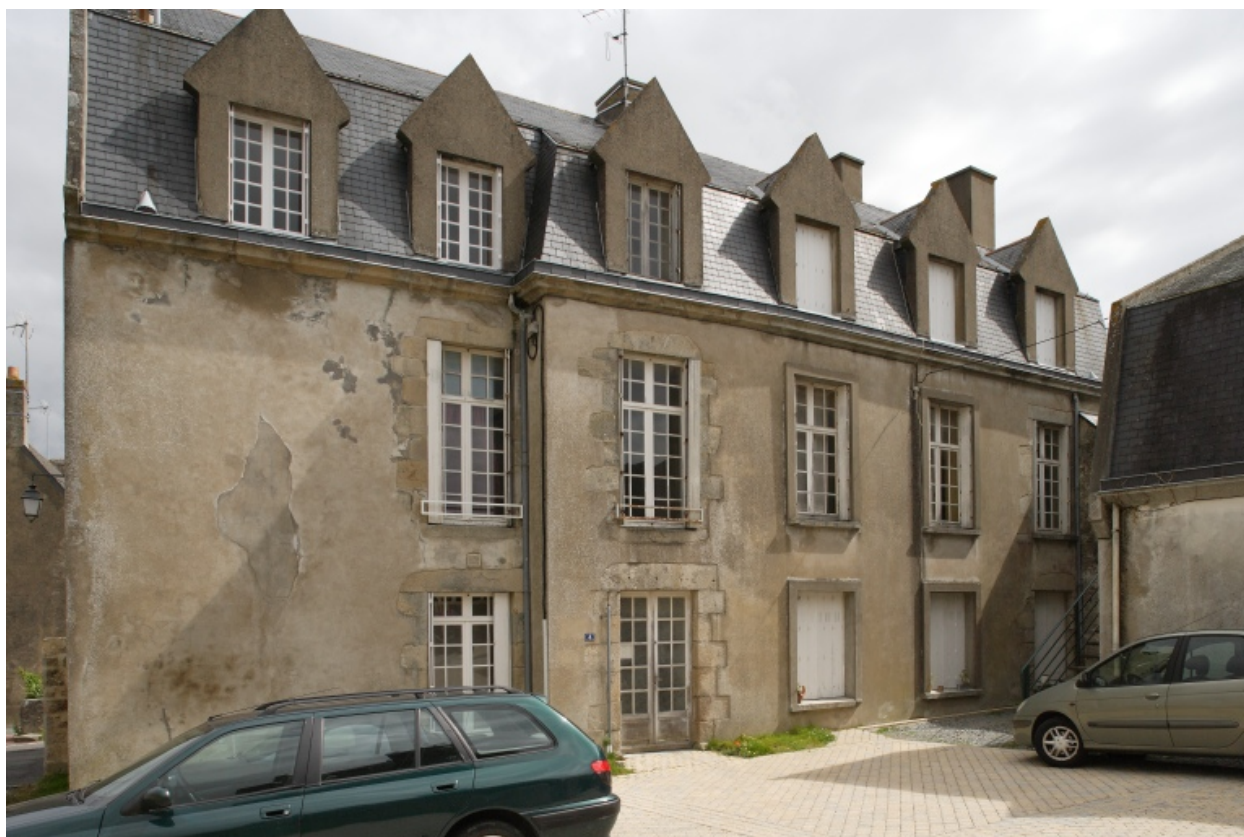
Vue de la façade sud.
