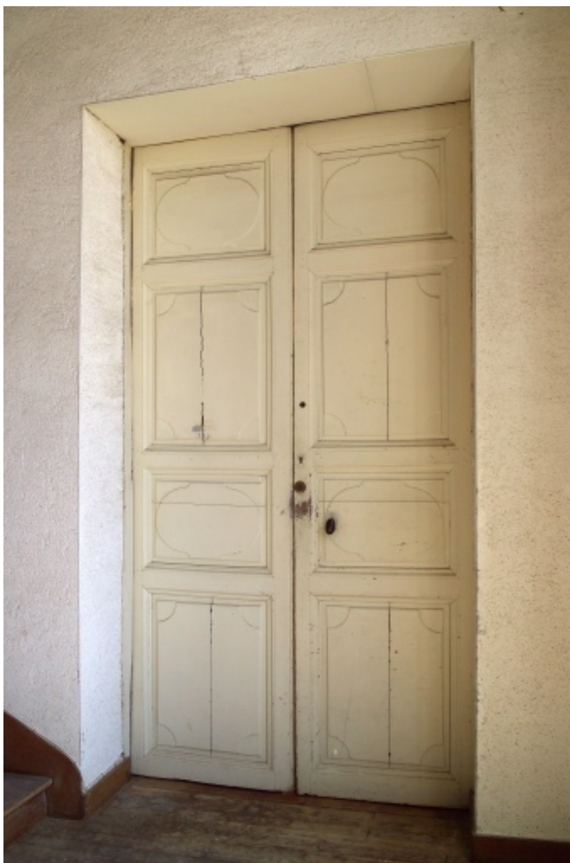
Porte de l'appartement est, premier étage.
