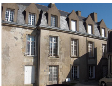
Vue de la façade sud. Phot. Frédéric Dufrêche IVR52_20074405043NUCA
