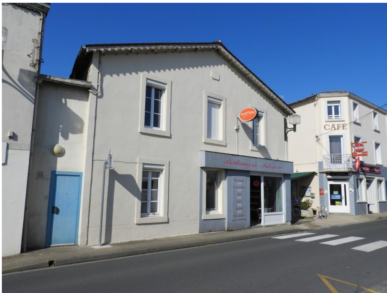
La boulangerie vue depuis le nord-est.
