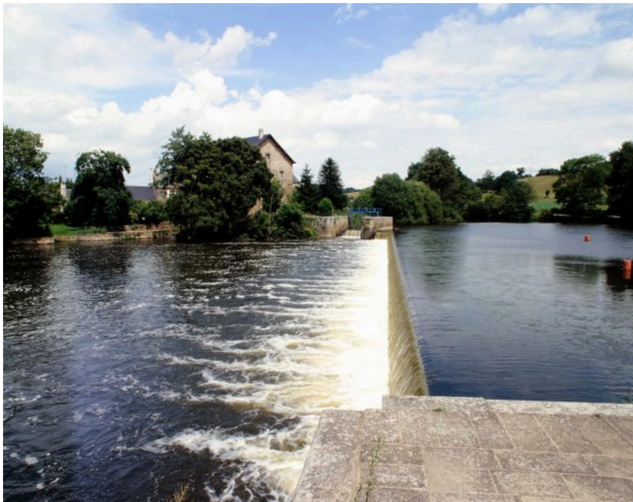
Le moulin, le pertuis et le barrage vus d'aval, depuis l'extrémité de la digue séparant la rivière du canal d'accès à l'écluse.
