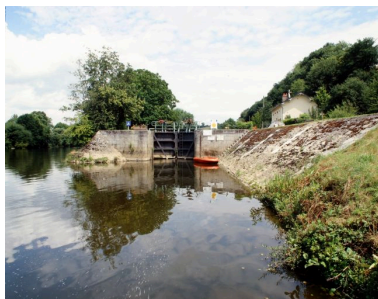
L'écluse et la maison éclusière vus de la rive gauche en aval. Phot. François Lasa IVR52_20025300989XA
