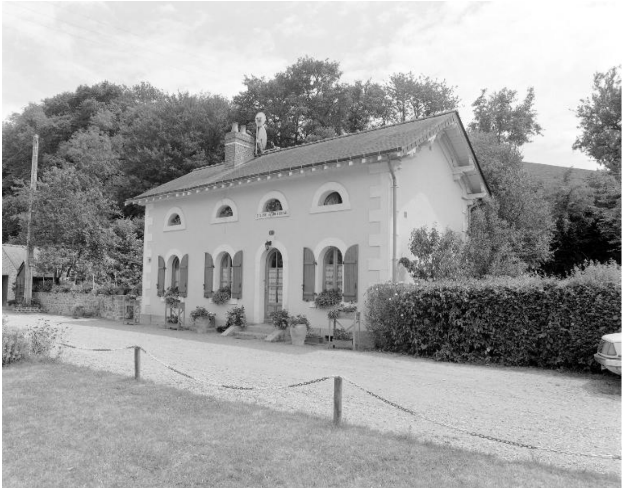
La maison éclusière.
