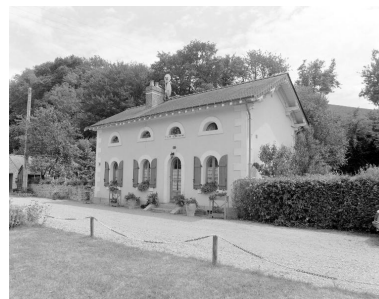
La maison éclusière. Phot. François Lasa IVR52_20025300990X
