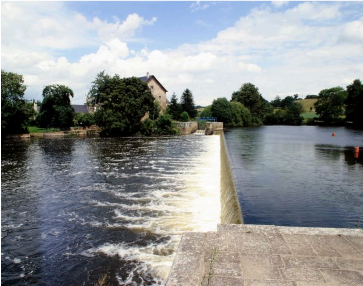
Le moulin, le pertuis et le barrage vus d'aval, depuis l'extrémité de la digue séparant la rivière du canal d'accès à l'écluse.
