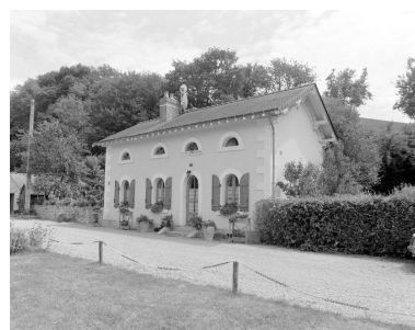
La maison éclusière. Phot. François Lasa IVR52_20025300990X
