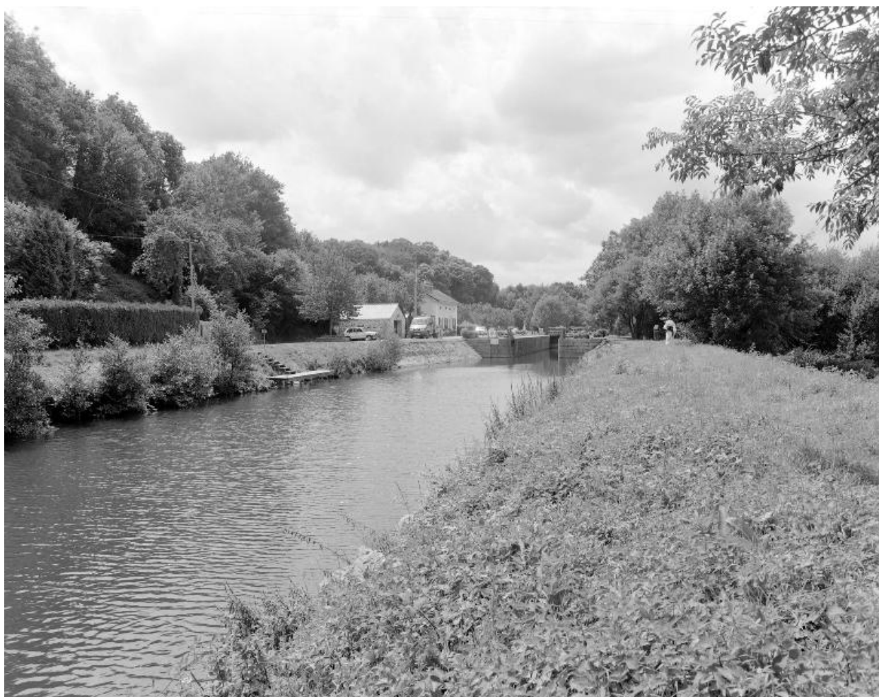
Le canal et l'écluse vus d'amont depuis la digue.
