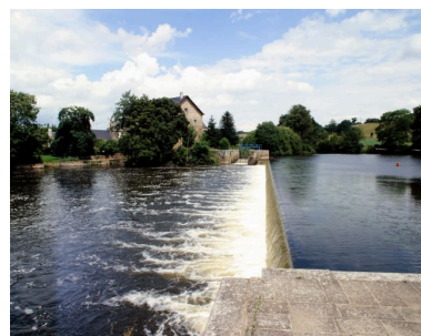
Le moulin, le pertuis et le barrage vus d'aval, depuis l'extrémité de la digue séparant la rivière du canal d'accès à l'écluse. Phot. François Lasa IVR52_20025300992XA
