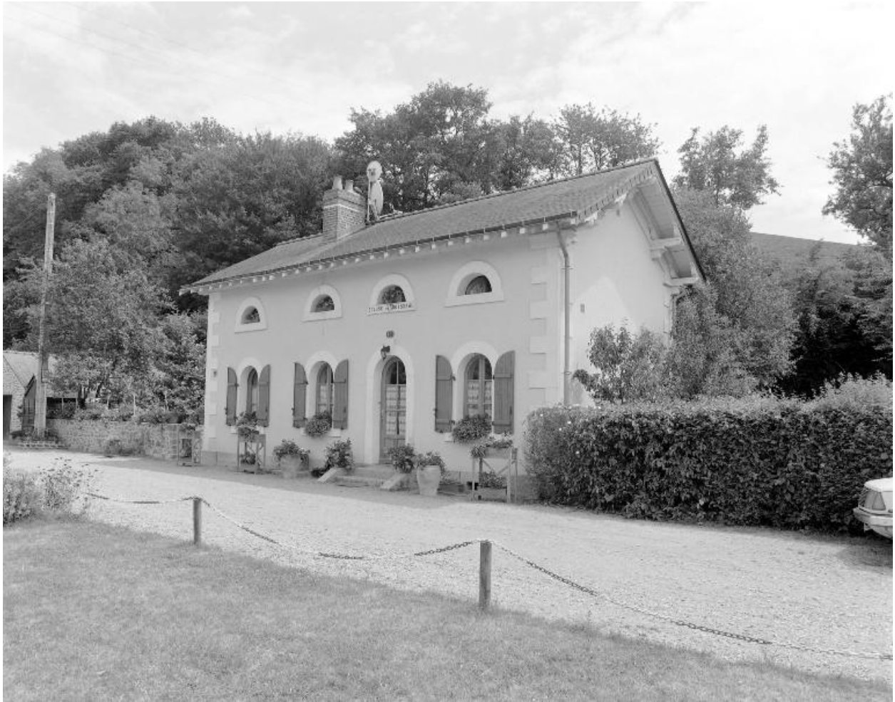
La maison éclusière.
