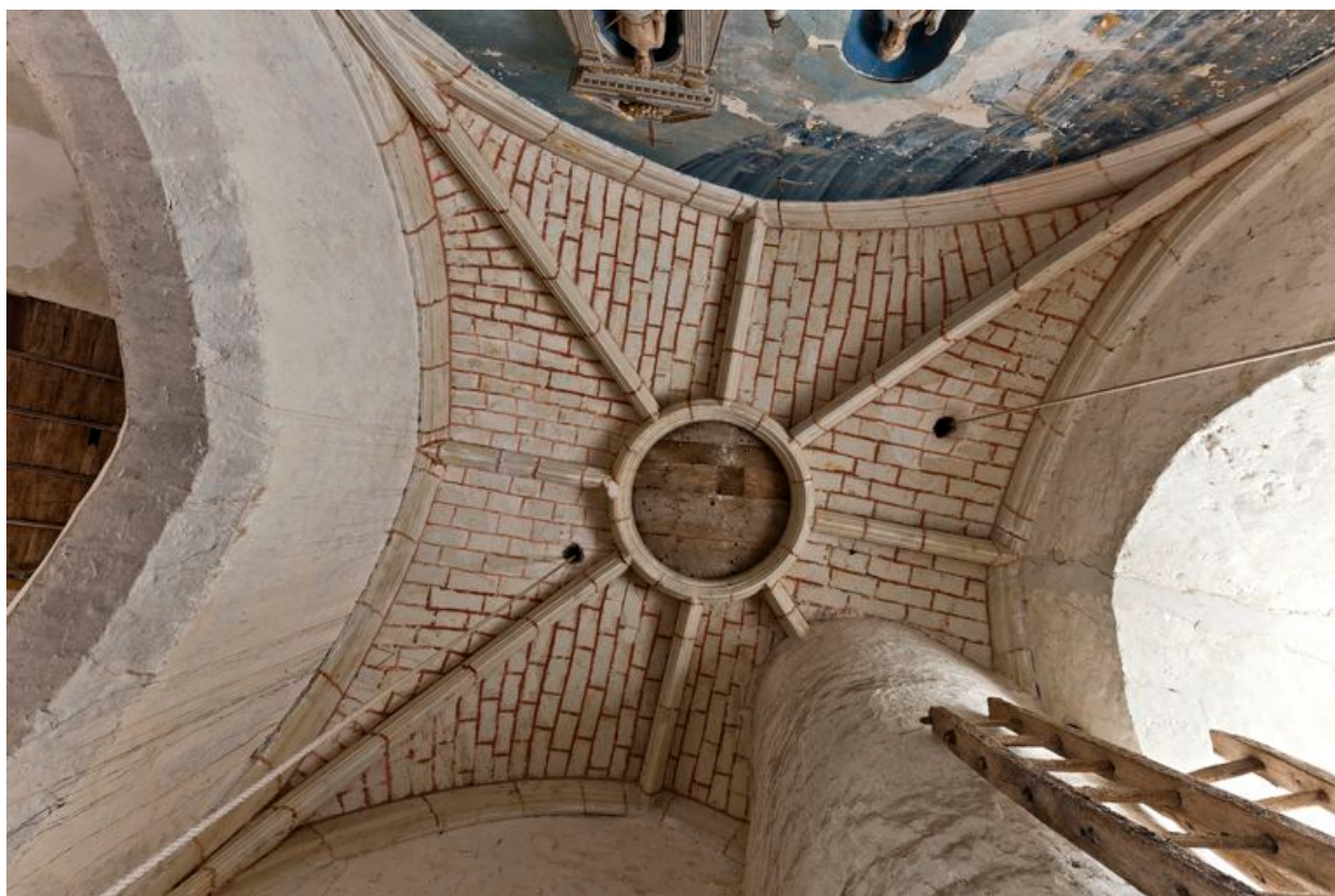
Vue d'ensemble de la voûte.
