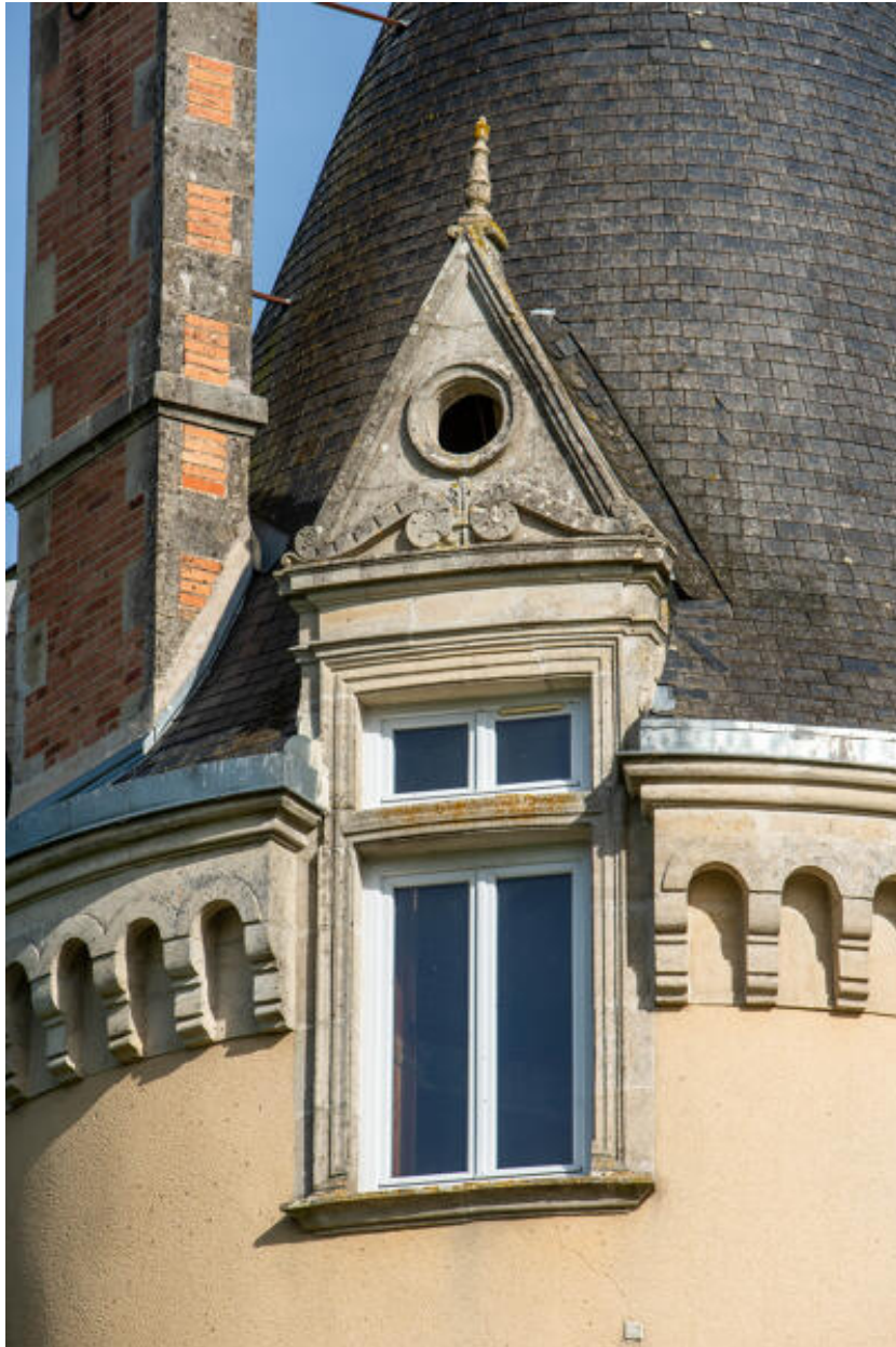
Un détail d'une lucarne d'une tour.
