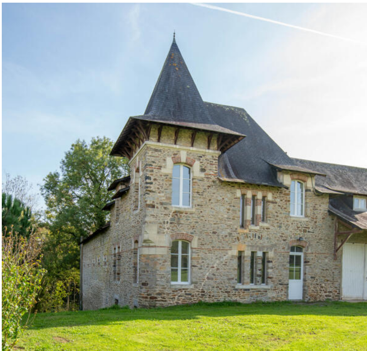
Les communs, le logis du fermier.
