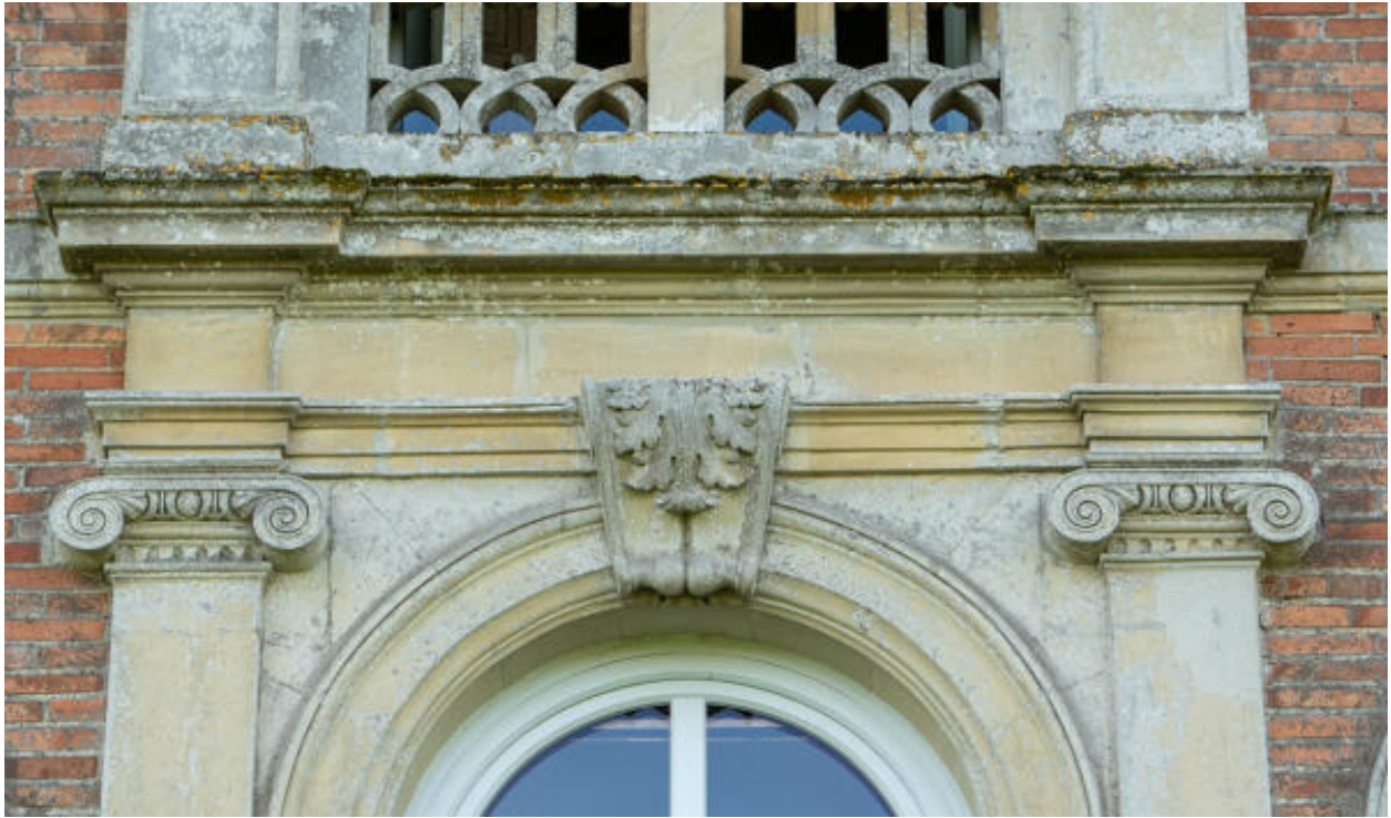
L'élévation postérieure, détail des décors de la travée centrale.
