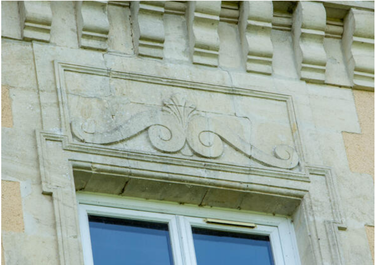
L'élévation postérieure, détail du linteau d'une fenêtre.
