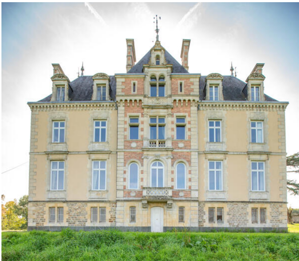
L'élévation postérieure du château.
