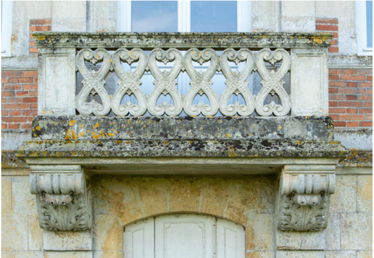
L'élévation postérieure, détail du balcon.
