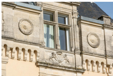
Le pavillon central : détail de la fenêtre supérieure. Phot. Pierre-Bernard Fourny IVR52_20225301030NUCA
