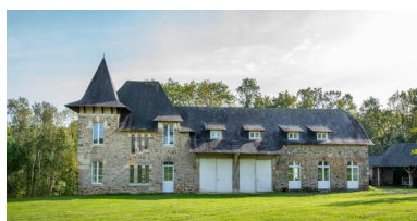
Les communs. Phot. Pierre-Bernard Fourny IVR52_20225301021NUCA
