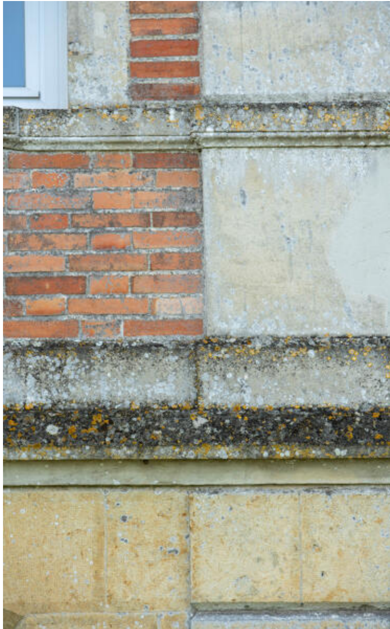
L'élévation postérieure, détail des maçonneries.
