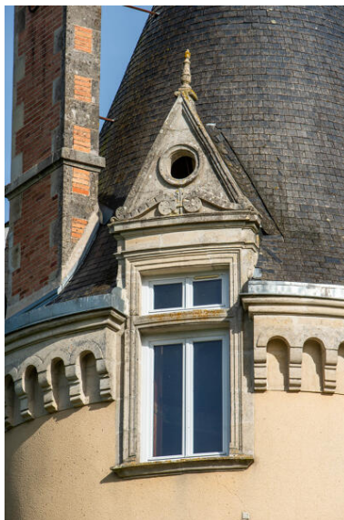
Un détail d'une lucarne d'une tour. Phot. Pierre-Bernard Fourny IVR52_20225301028NUCA
