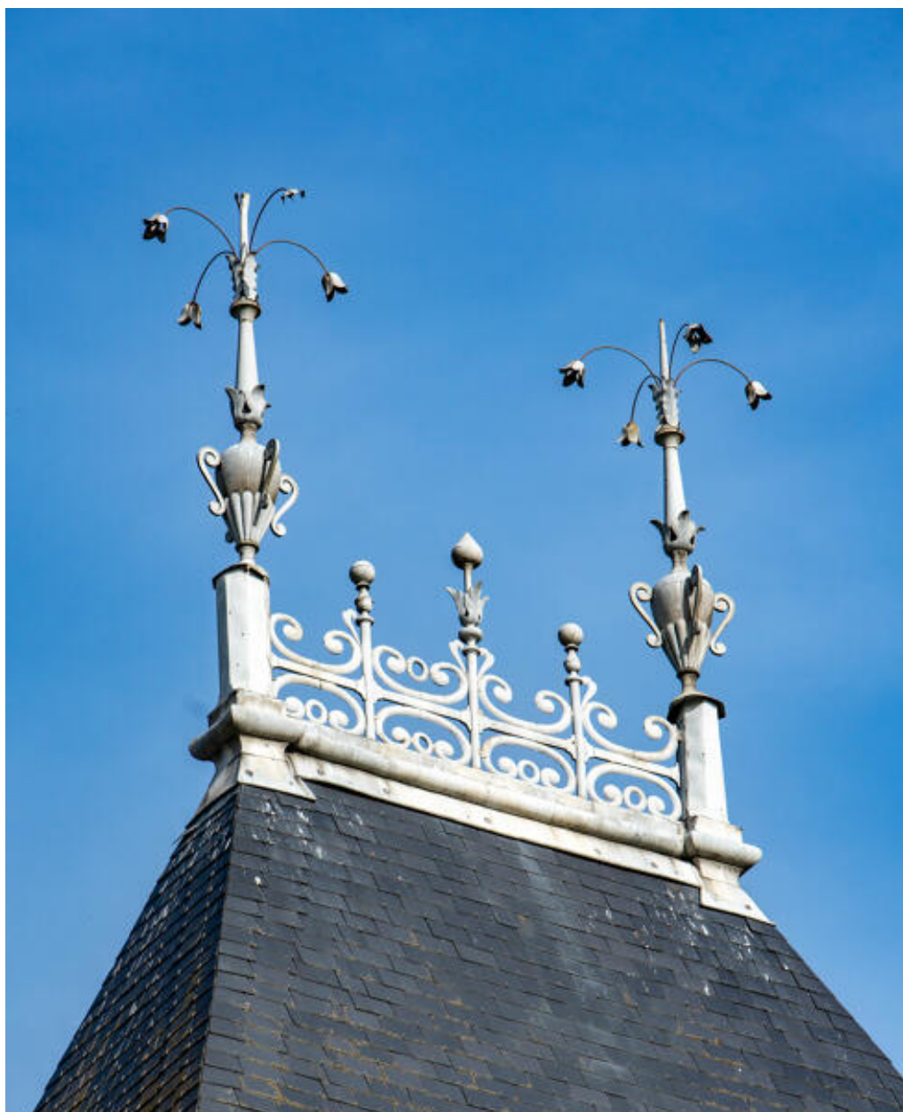
Le pavillon central : détail des épis de faîtage.
