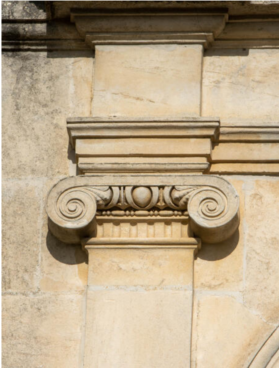
La porte du château, détail d'un pilastre.
