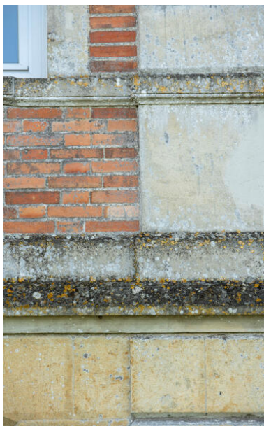
L'élévation postérieure, détail des maçonneries. Phot. Pierre-Bernard Fourny IVR52_20225301040NUCA
