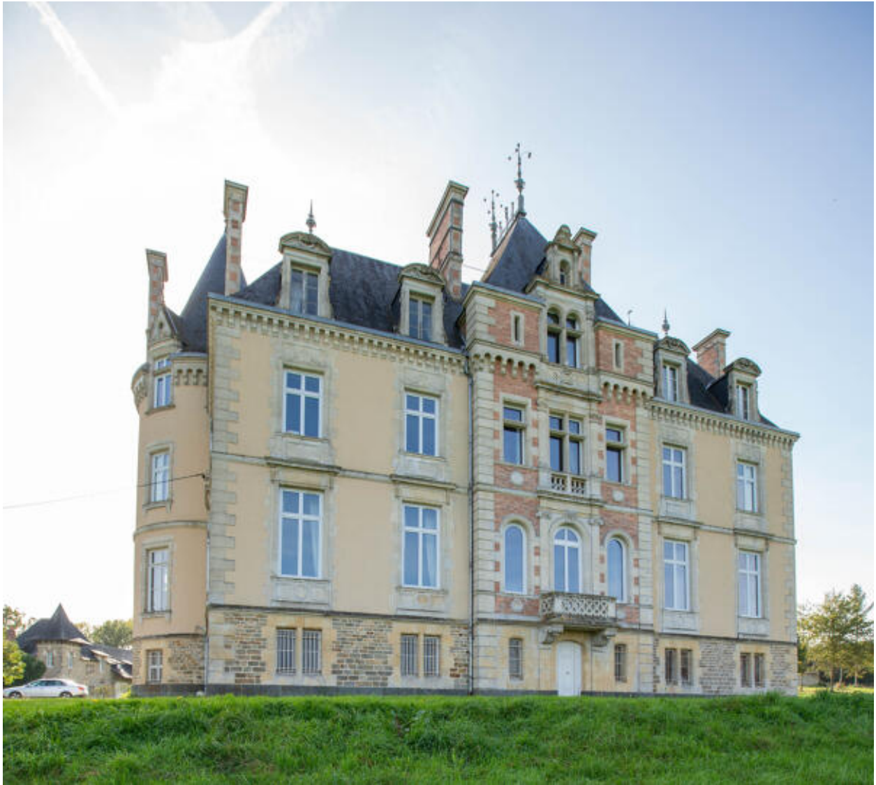
L'élévation postérieure du château.
