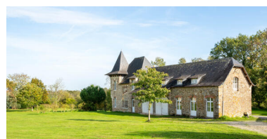
Les communs. Repro. Pierre-Bernard Fourny IVR52_20225301069NUCA
