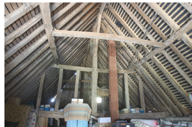
La charpente du logis : fermes ouest.
