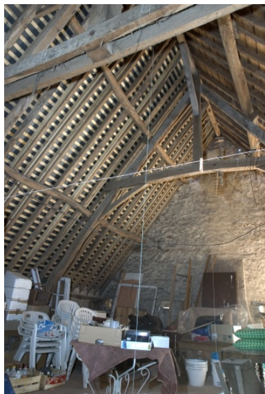
La charpente du logis : ferme est. Phot. François Lasa IVR52_20045302546NUCA
