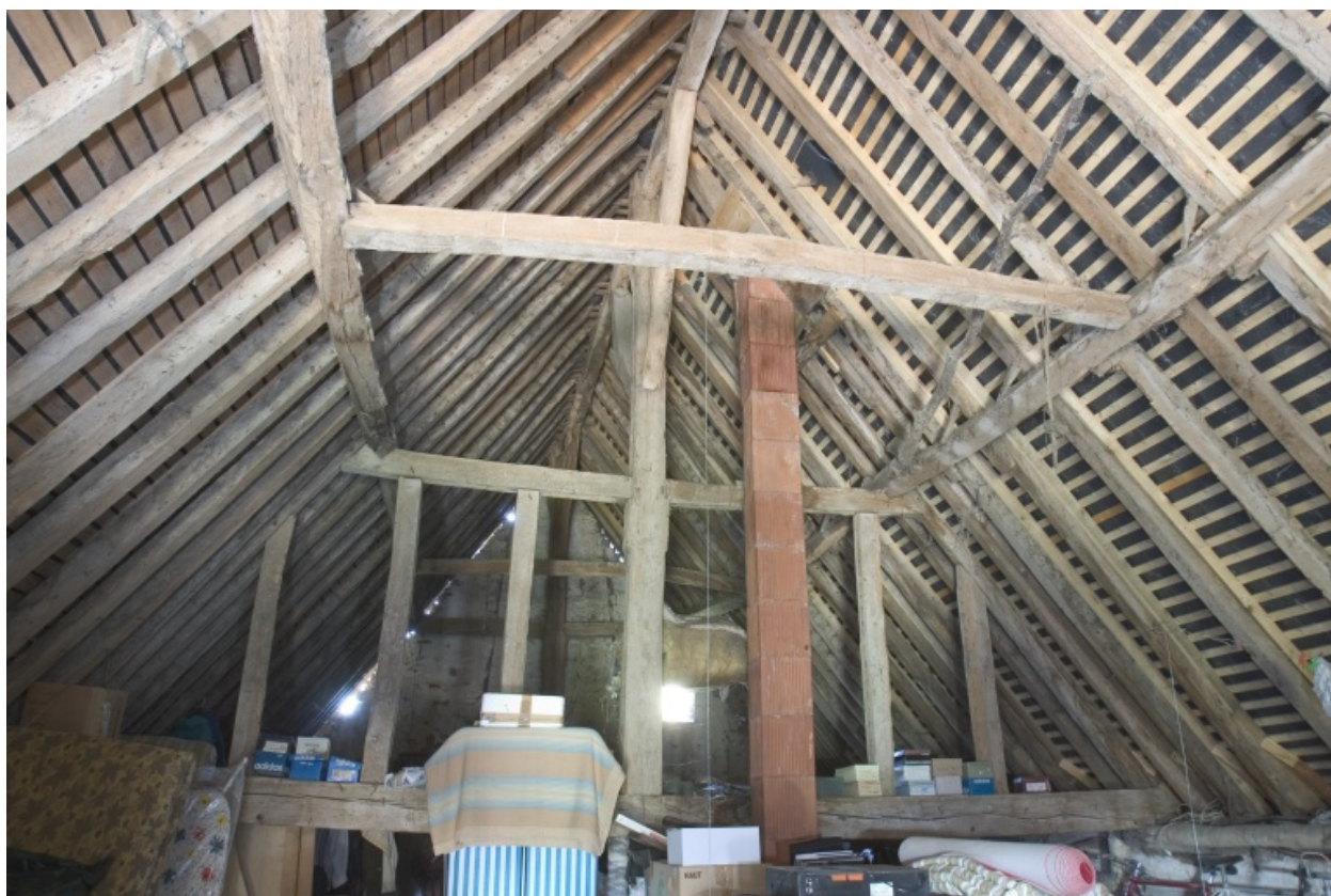
La charpente du logis : fermes ouest.
