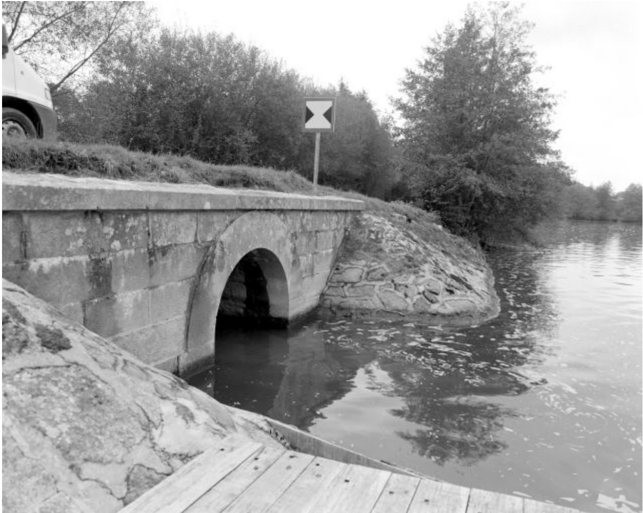
Pont enjambant le ruisseau d'Ouvrain à l'endroit où il se jette dans la Mayenne, immédiatement en aval du barrage de la Verrerie.
