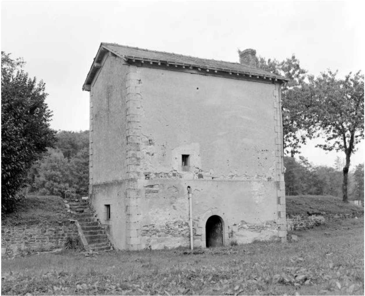
Façade postérieure de la maison éclusière.
