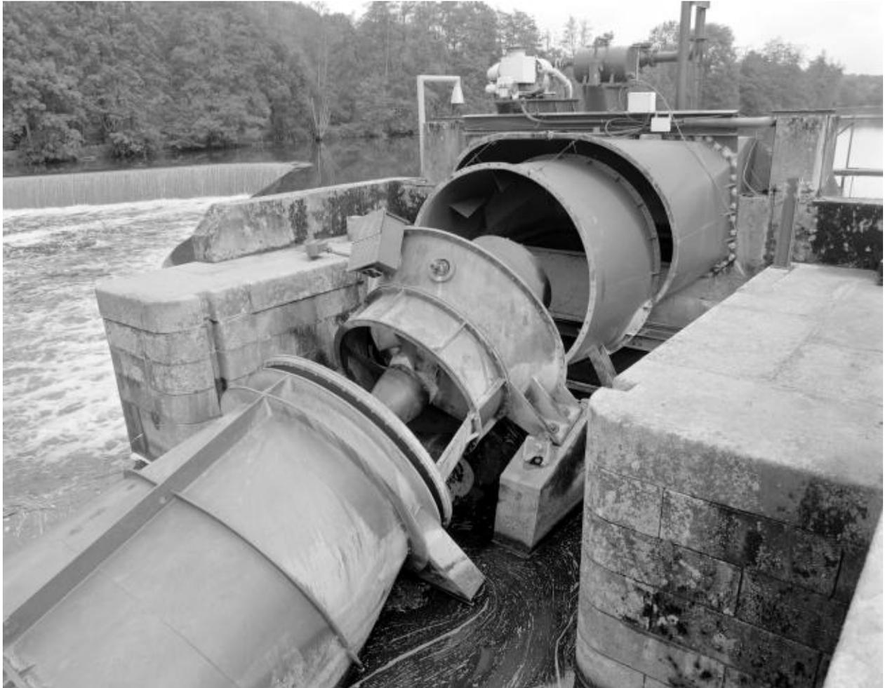
Le siphon, la turbine et le générateur de la centrale hydroélectrique.
