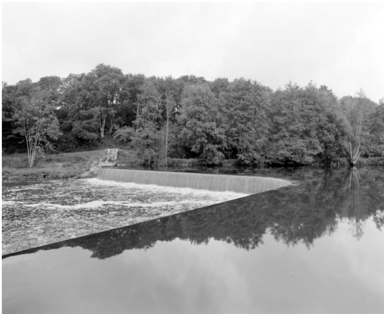
Le barrage vu depuis l'écluse.
