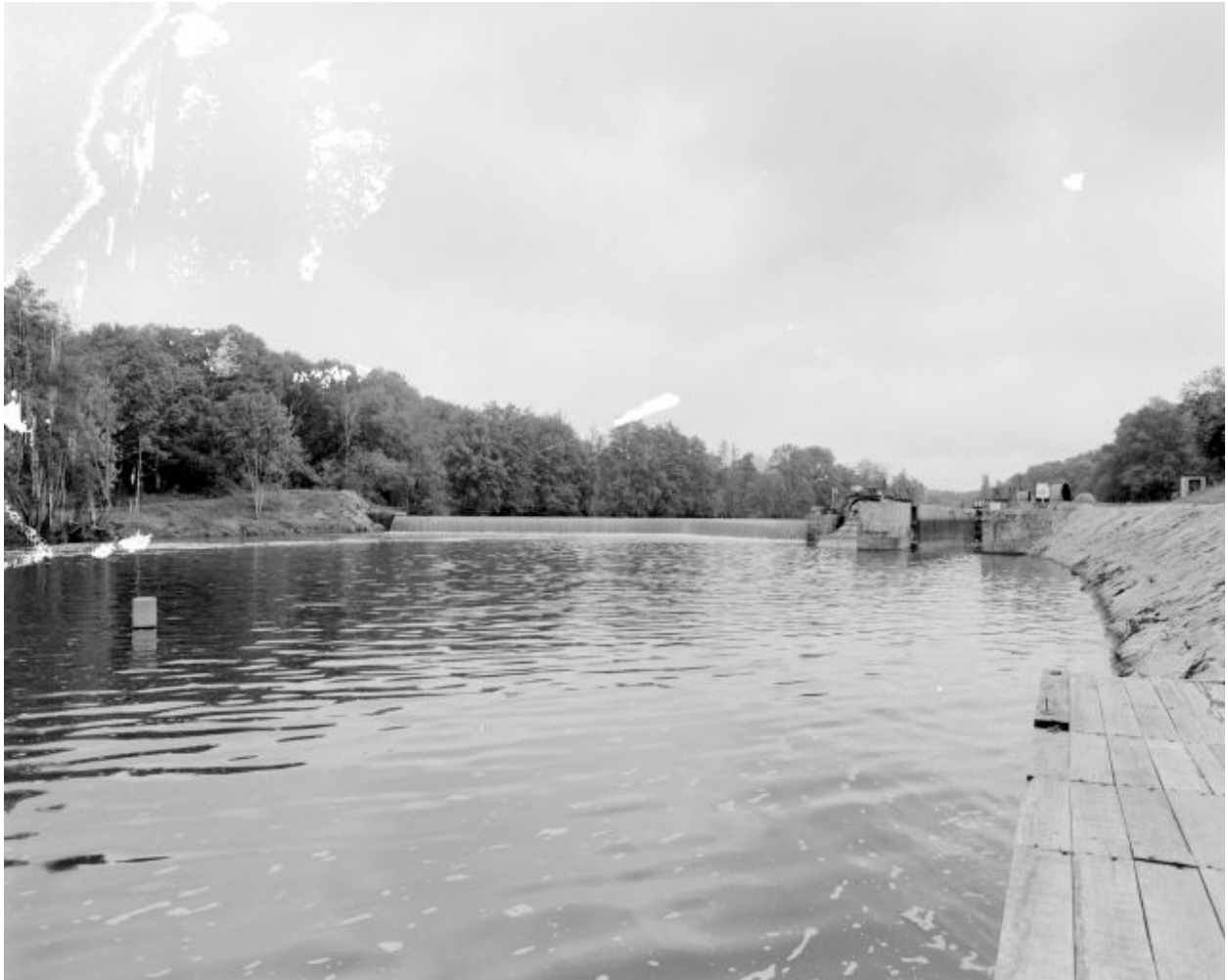
Vue d'ensemble du site d'écluse depuis le ponton situé en aval sur la rive gauche : barrage, centrale hydroélectrique, écluse, transformateur.
