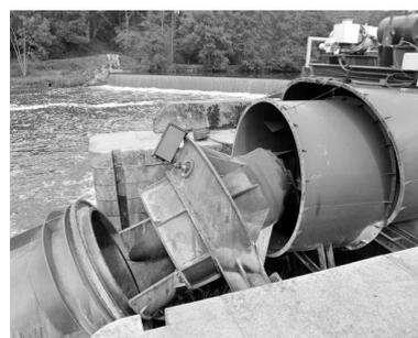
La turbine et le générateur de la centrale hydroélectrique.
