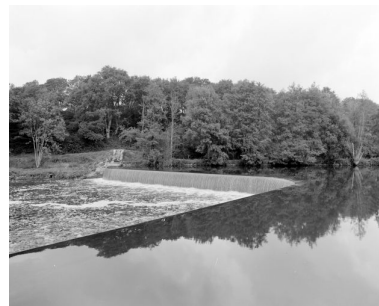
Le barrage vu depuis l'écluse. Phot. François Lasa IVR52_20015300571X
