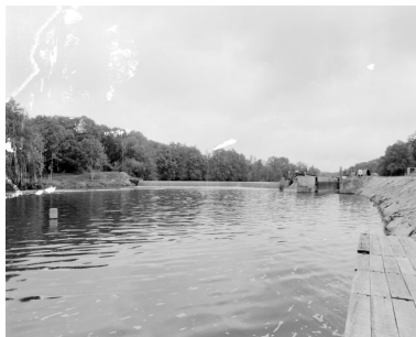
Vue d'ensemble du site d'écluse depuis le ponton situé en aval sur la rive gauche : barrage, centrale hydroélectrique, écluse, transformateur. Phot. François Lasa IVR52_20015300563X
