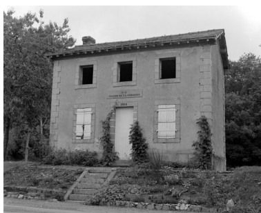
Façade antérieure de la maison éclusière. Phot. François Lasa IVR52_20015300565X
