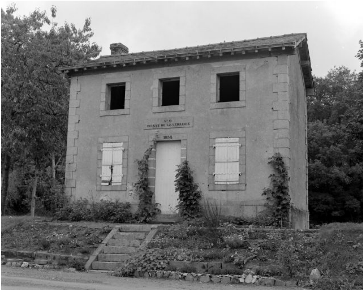
Façade antérieure de la maison éclusière.
