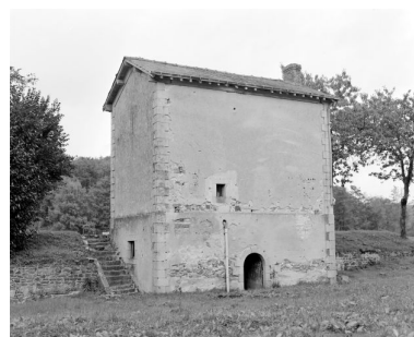
Façade postérieure de la maison éclusière. Phot. François Lasa IVR52_20015300566X
