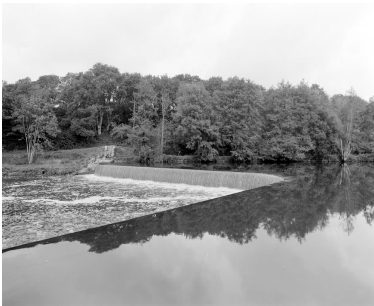
Le barrage vu depuis l'écluse.
