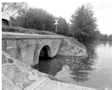
Pont enjambant le ruisseau d'Ouvrain à l'endroit où il se jette dans la Mayenne, immédiatement en aval du barrage de la Verrerie. Phot. François Lasa IVR52_20015300564X
