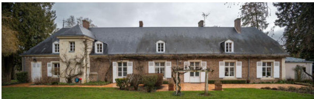
Le logis : façade arrière.
