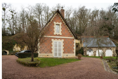
Pignon de l'étable et écurie sous même faîte, remise et atelier (à droite) et aménagements troglodytiques (à gauche). Phot. Jeanne Minier IVR52_20267200190NUCA
