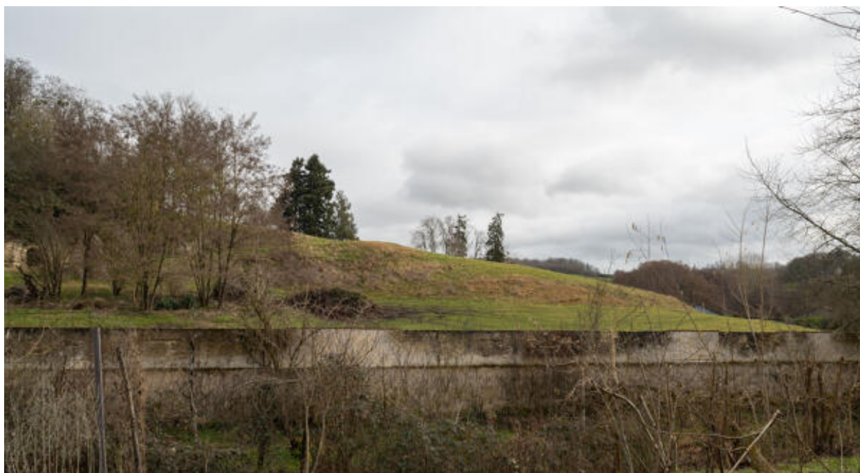
Mur de clôture, vu depuis le sud-ouest.
