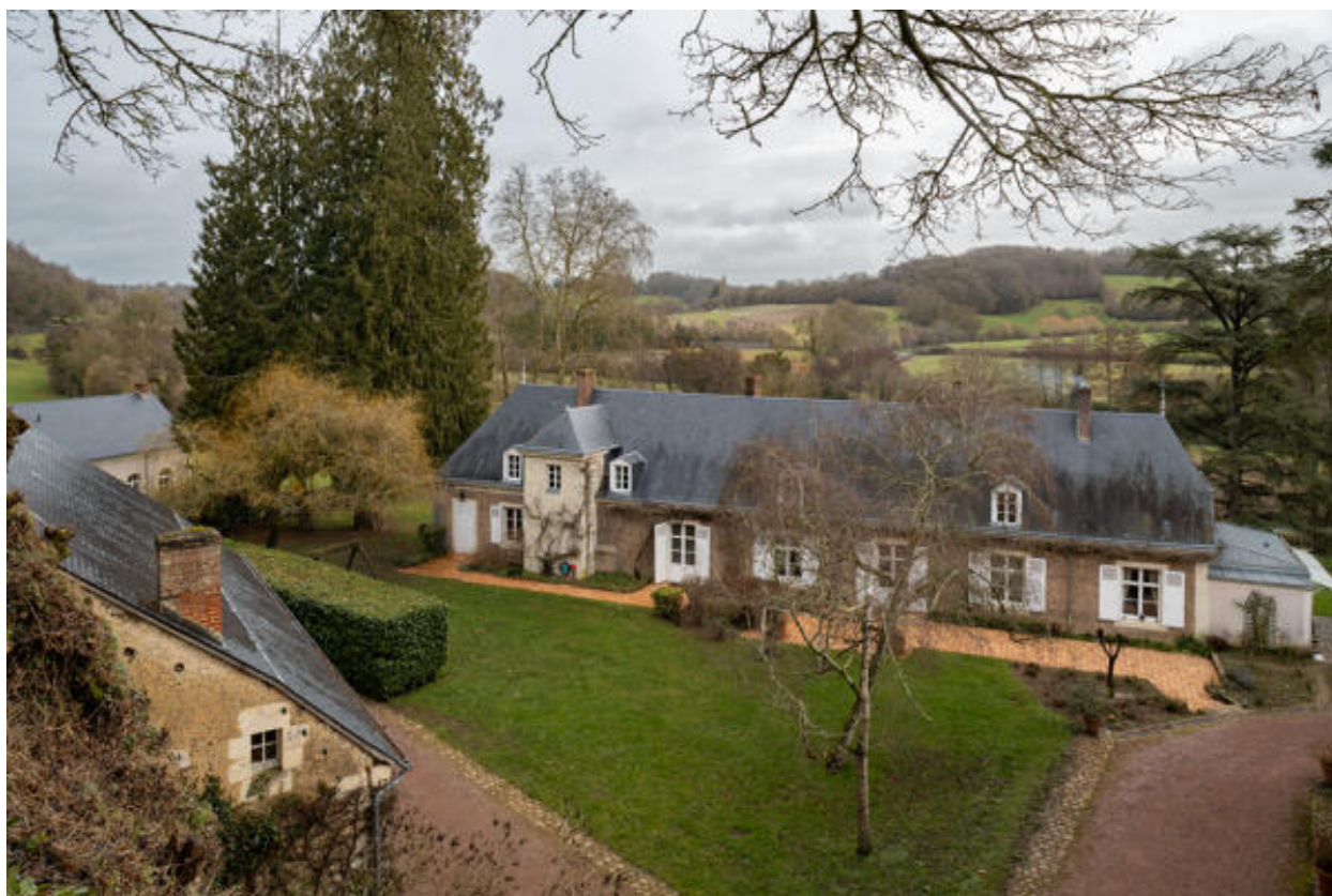
Vue d'ensemble depuis un point en surplomb sur le coteau.
