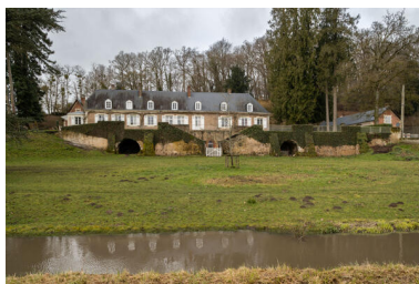
Vue d'ensemble depuis l'est. Phot. Jeanne Minier IVR52_20267200199NUCA
