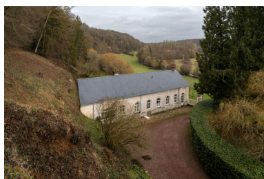
Parties agricoles et logement sous même faîte, vus en surplomb depuis le coteau. Phot. Jeanne Minier IVR52_20267200193NUCA
