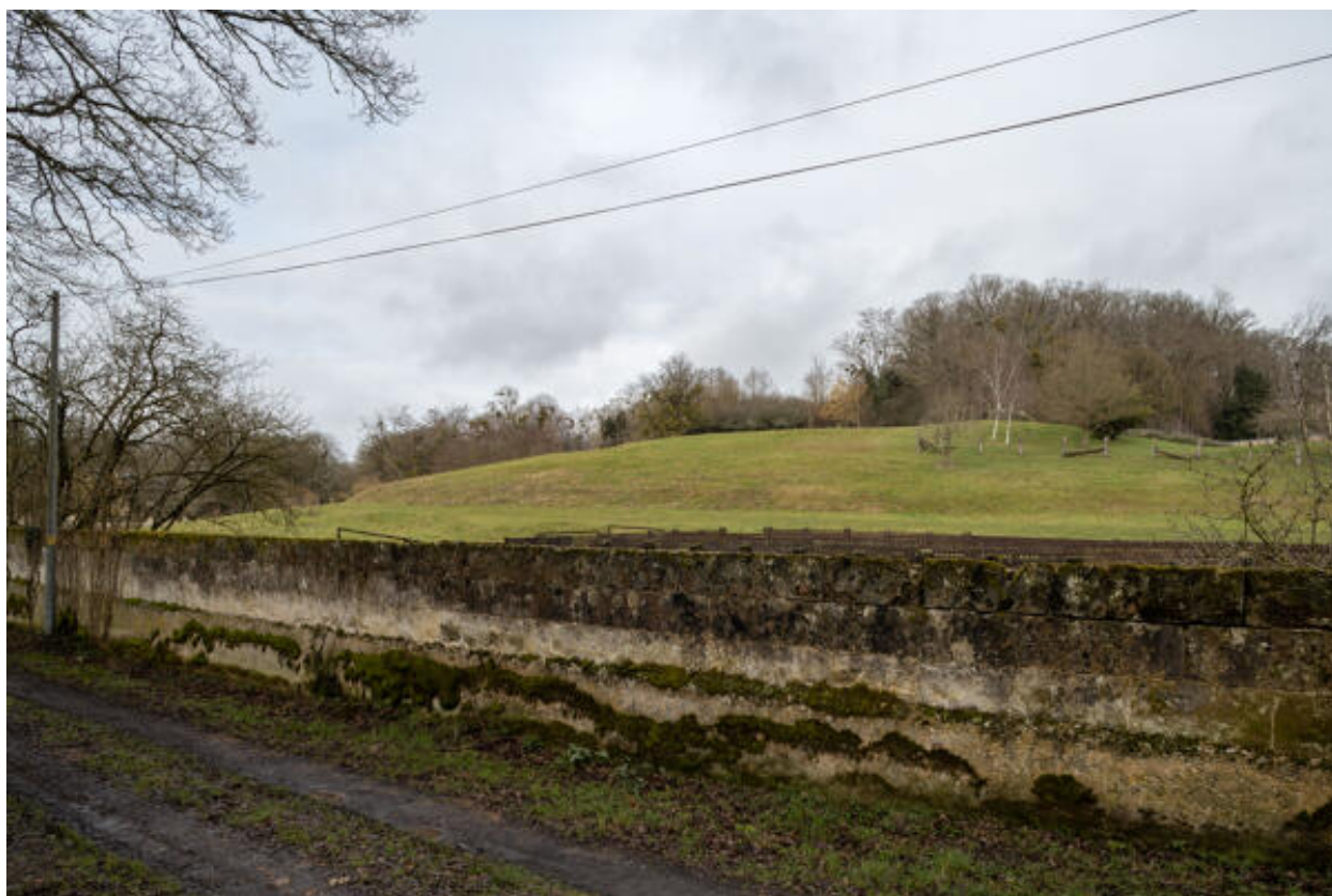
Mur de clôture, vu depuis le sud.
