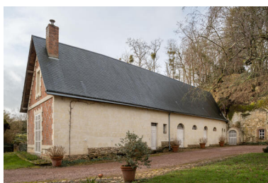
Étable et écurie sous même faîte. Phot. Jeanne Minier IVR52_20267200196NUCA
