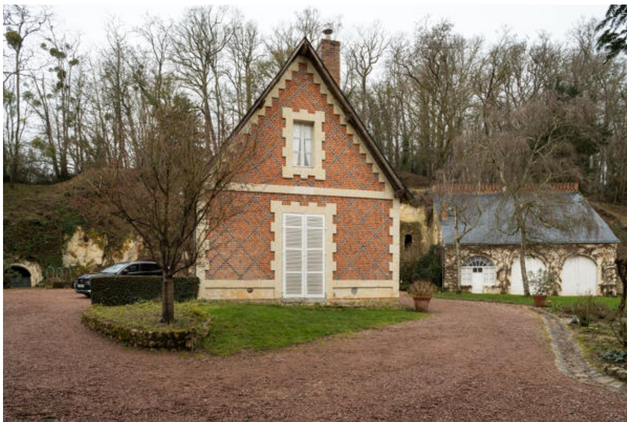
Pignon de l'étable et écurie sous même faîte, remise et atelier (à droite) et aménagements troglodytiques (à gauche).
