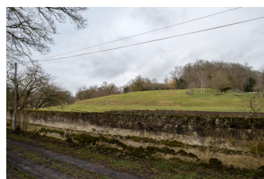
Mur de clôture, vu depuis le sud. Phot. Jeanne Minier IVR52_20267200201NUCA
