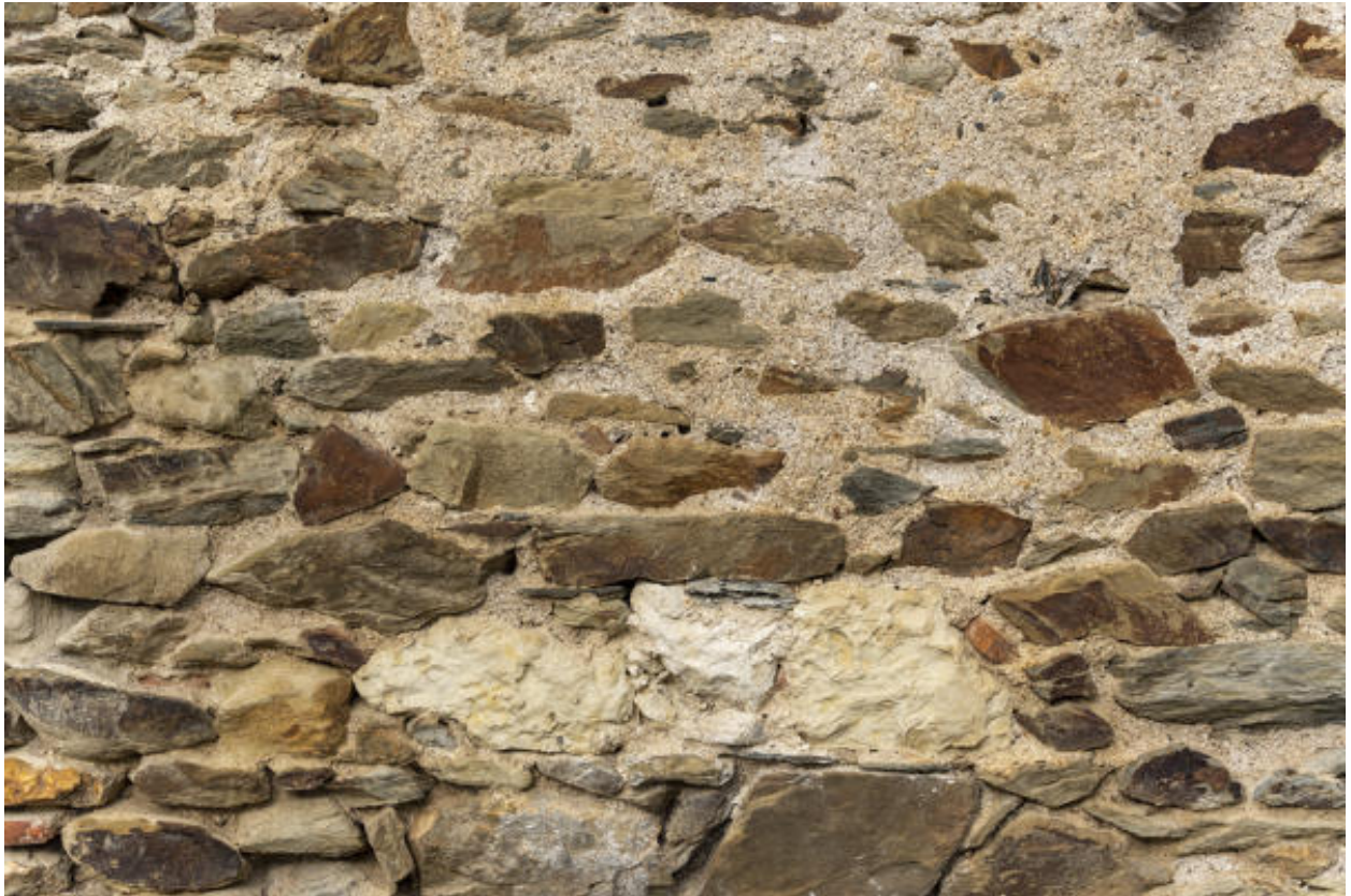
Un détail de la maçonnerie.
