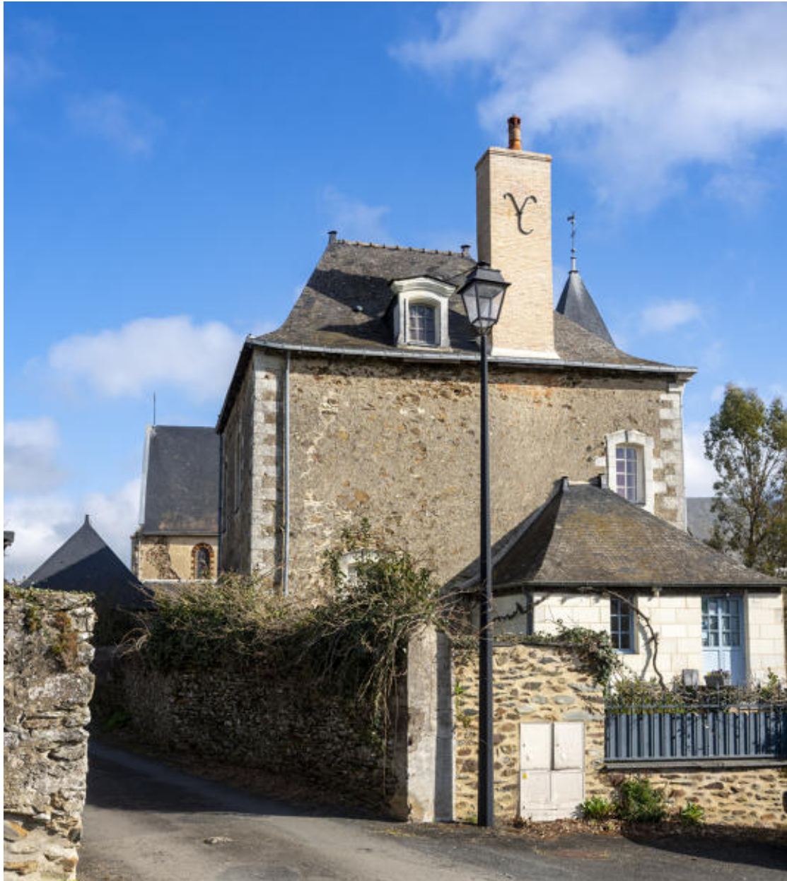
La façade latérale.
