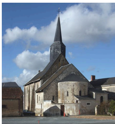
Vue d'ensemble du chevet. Phot. Jean-Baptiste Darrasse IVR52_20057203841NUCA
