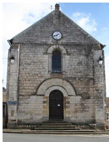
Façade occidentale. Phot. Jean-Baptiste Darrasse IVR52_20057203848NUCA
