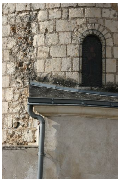
Abside en cul de four : baie cintrée. Phot. Jean-Baptiste Darrasse IVR52_20057203843NUCA
