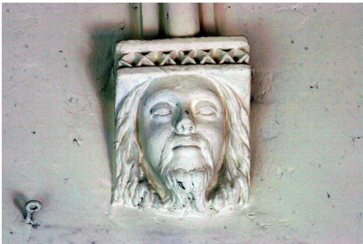
Voûte de l'abside : culot 8
