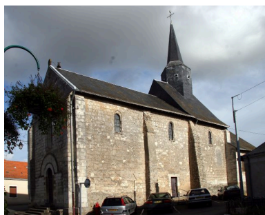
Façade méridionale. Phot. Jean-Baptiste Darrasse IVR52_20057203845NUCA
