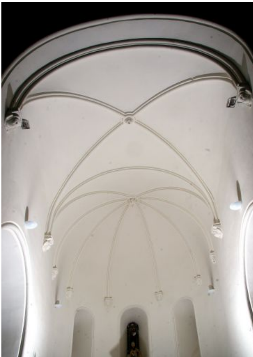
Ogives sur une voûte en berceau.
