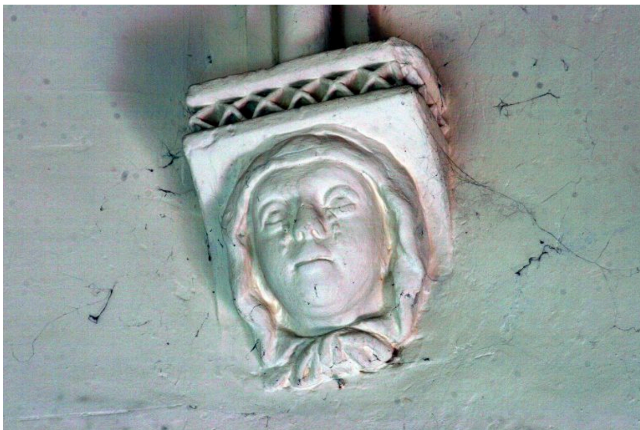
Voûte du chœur : culot 9.
