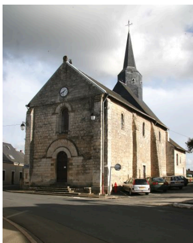
Vue de volume prise du sud-ouest. Phot. Jean-Baptiste Darrasse IVR52_20057203847NUCA
