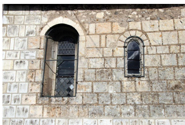
Mur sud du chœur, baies. Phot. Jean-Baptiste Darrasse IVR52_20057203844NUCA
