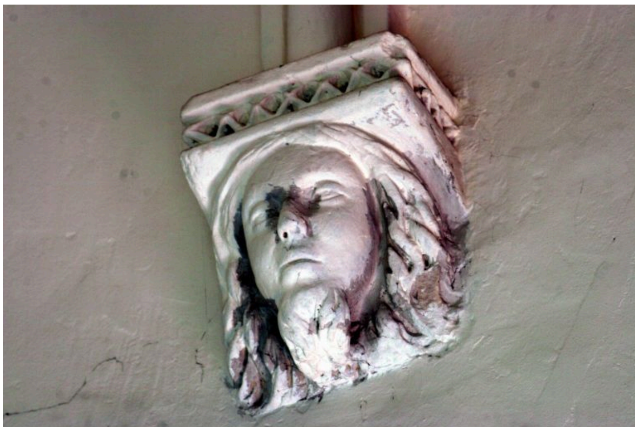
Voûte du chœur : culot 10.
