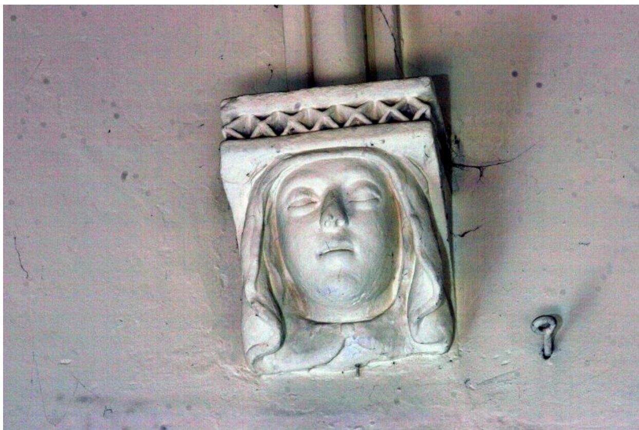
Voûte de l'abside : culot 7.
