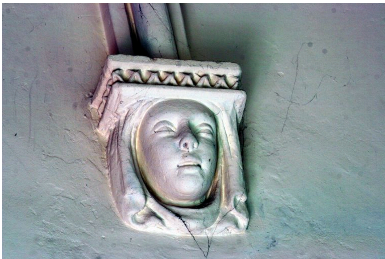
Voûte de l'abside : culot 5.
