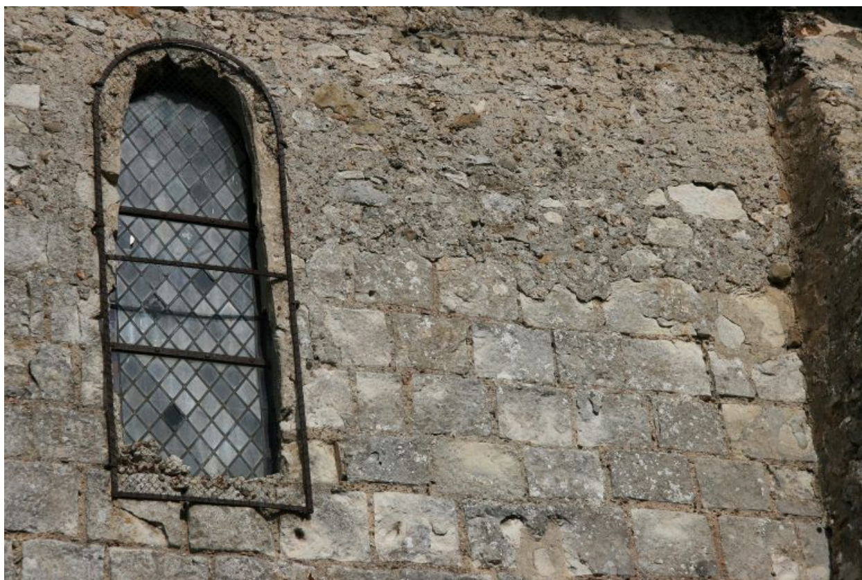
Mur sud de la nef, baie.
