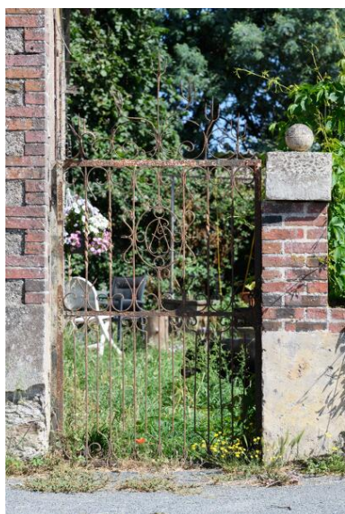
Détail du portillon en fer forgé portant au centre l'initiale "A" pour "Angebault". Phot. Armelle Maugin IVR52_20254900904NUCA
