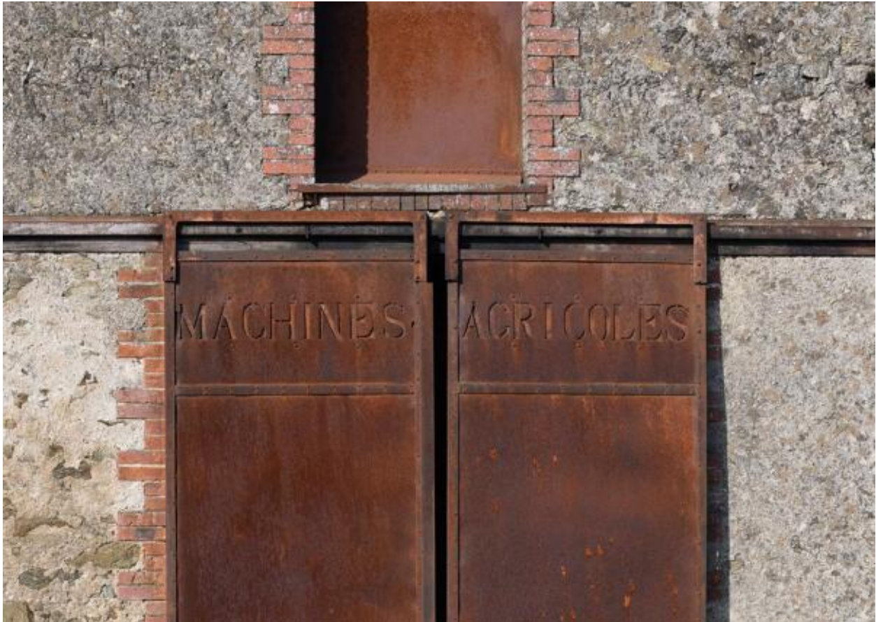
Détail des vantaux en fer du magasin gravés "MACHINES" et "AGRICOLES".
