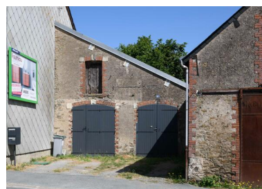
Atelier et magasin. Phot. Armelle Maugin IVR52_20254900906NUCA
