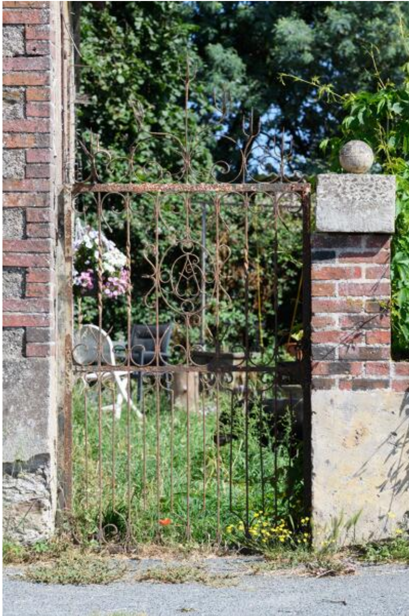
Détail du portillon en fer forgé portant au centre l'initiale "A" pour "Angebault".
