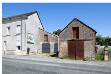
Vue d'ensemble du logis (à gauche), magasin et atelier de la forge Angebault. Phot. Armelle Maugin IVR52_20254900907NUCA
