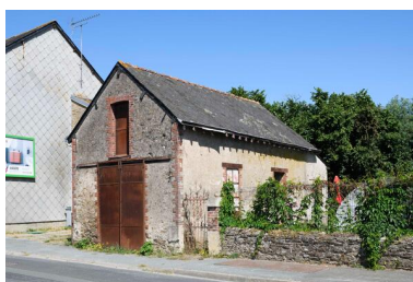
Magasin, depuis l'est. Phot. Armelle Maugin IVR52_20254900905NUCA
