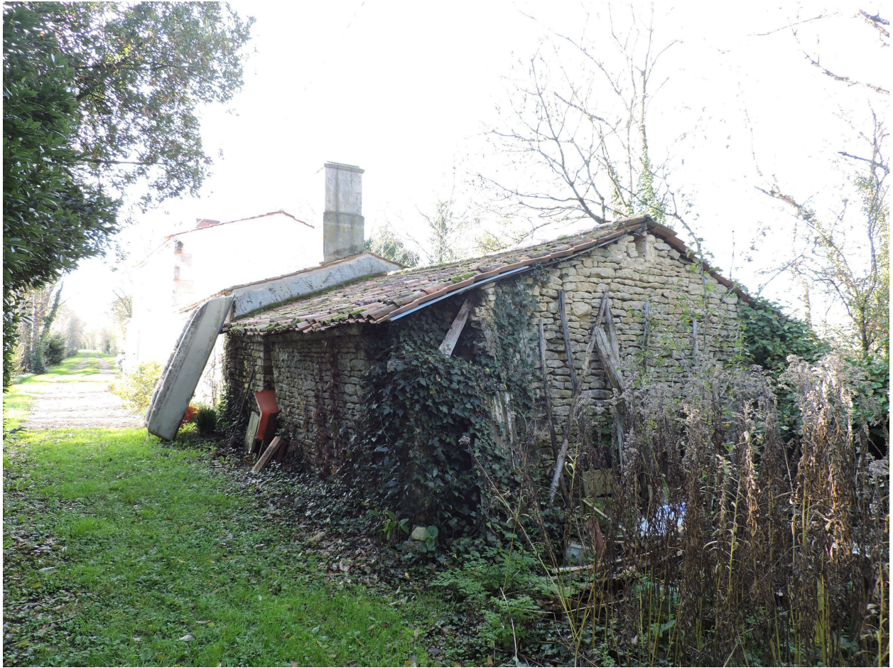
Les dépendances de la hutte, dans son prolongement à l'est, vues depuis l'est.
