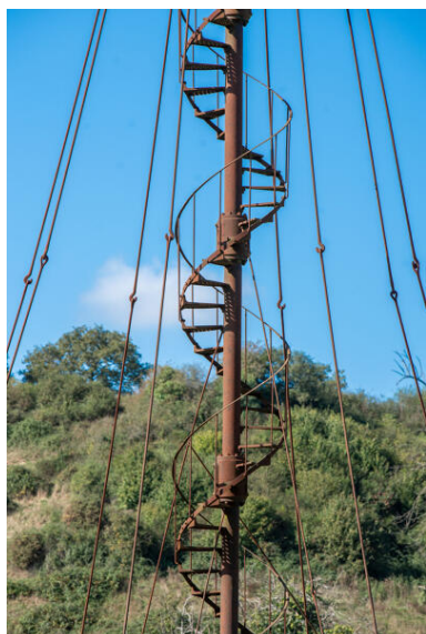
L'éolienne, détail. Phot. Pierre-Bernard Fourny IVR52_20235301509NUCA
