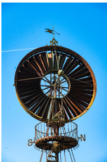
L'éolienne, détail. Phot. Pierre-Bernard Fourny IVR52_20235301507NUCA
