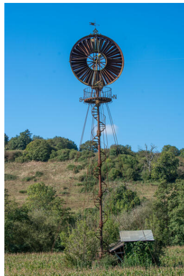
L'éolienne. Phot. Pierre-Bernard Fourny IVR52_20235301506NUCA
