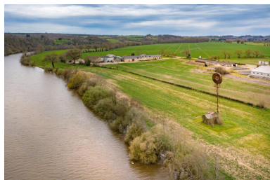
Une vue arienne de l'éolienne au bord de la Mayenne. Phot. Pierre-Bernard Fourny IVR52_20235300195NUCA
