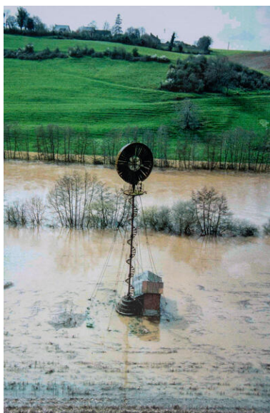
L'éolienne photographiée à la fin du XXe siècle. Phot. Pierre-Bernard Fourny IVR52_20235301371NUCA
