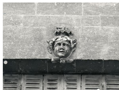
Elévation sur la rue Boisnet : 1er étage, mascaron de la travée centrale gauche. Phot. Patrice Giraud IVR52_19864900310X
