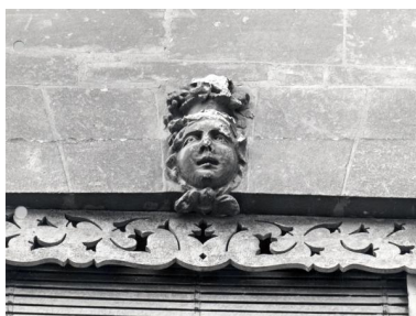
Elévation sur la rue Boisnet : 1er étage, mascaron de la travée gauche. Phot. Patrice Giraud IVR52_19864900311X
