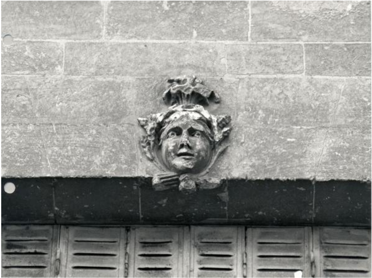
Elévation sur la rue Boisnet : 1er étage, mascaron de la travée centrale gauche.
