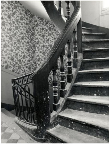
Escalier avec le palier du 1er étage.
