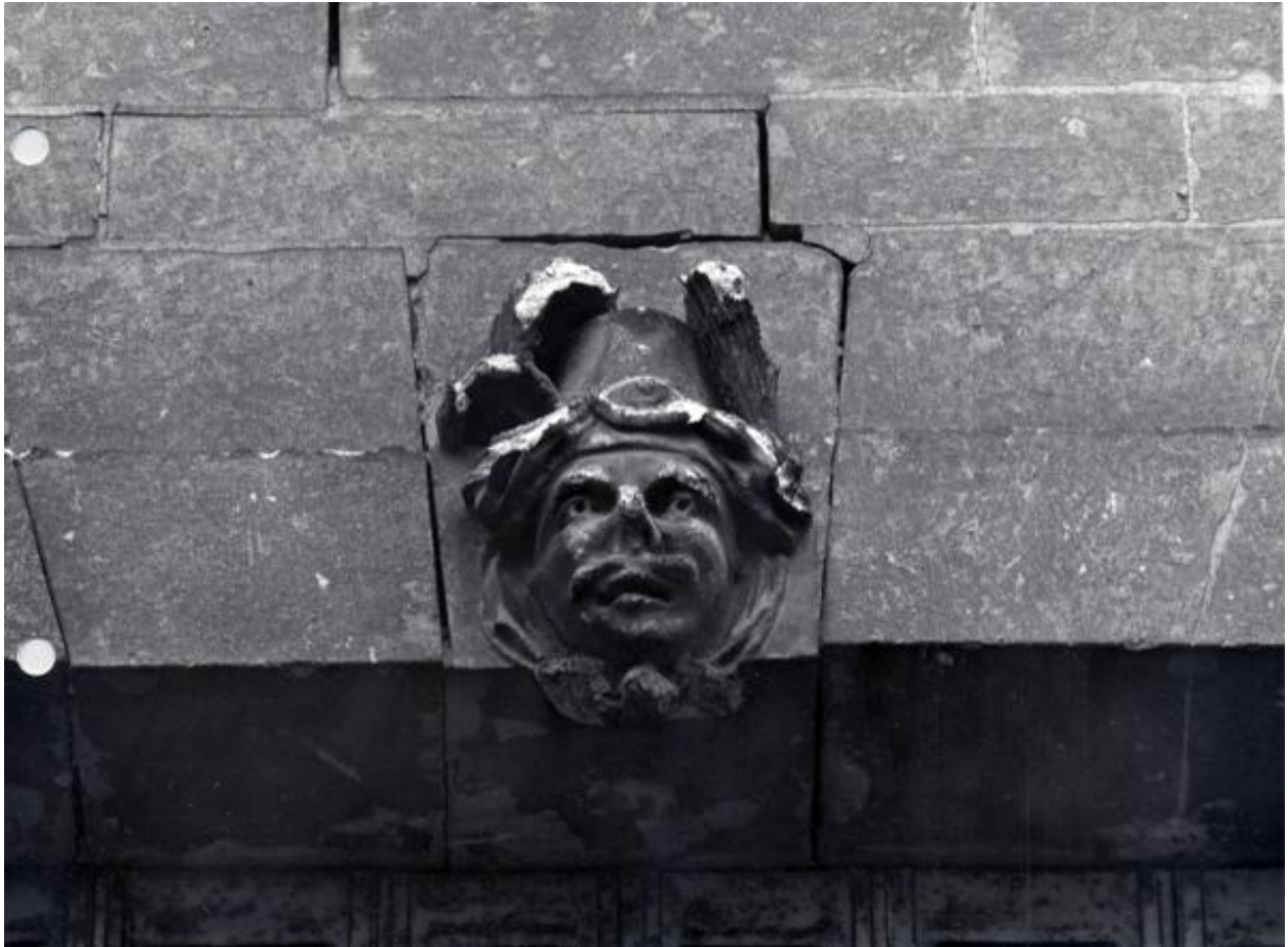
Elévation sur la rue Boisnet : 1er étage, mascaron de la travée droite.
