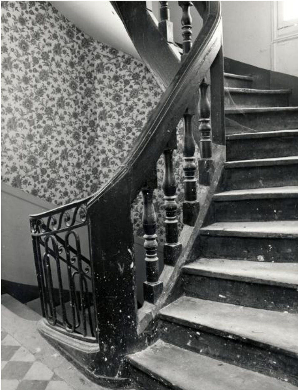
Escalier avec le palier du 1er étage.
