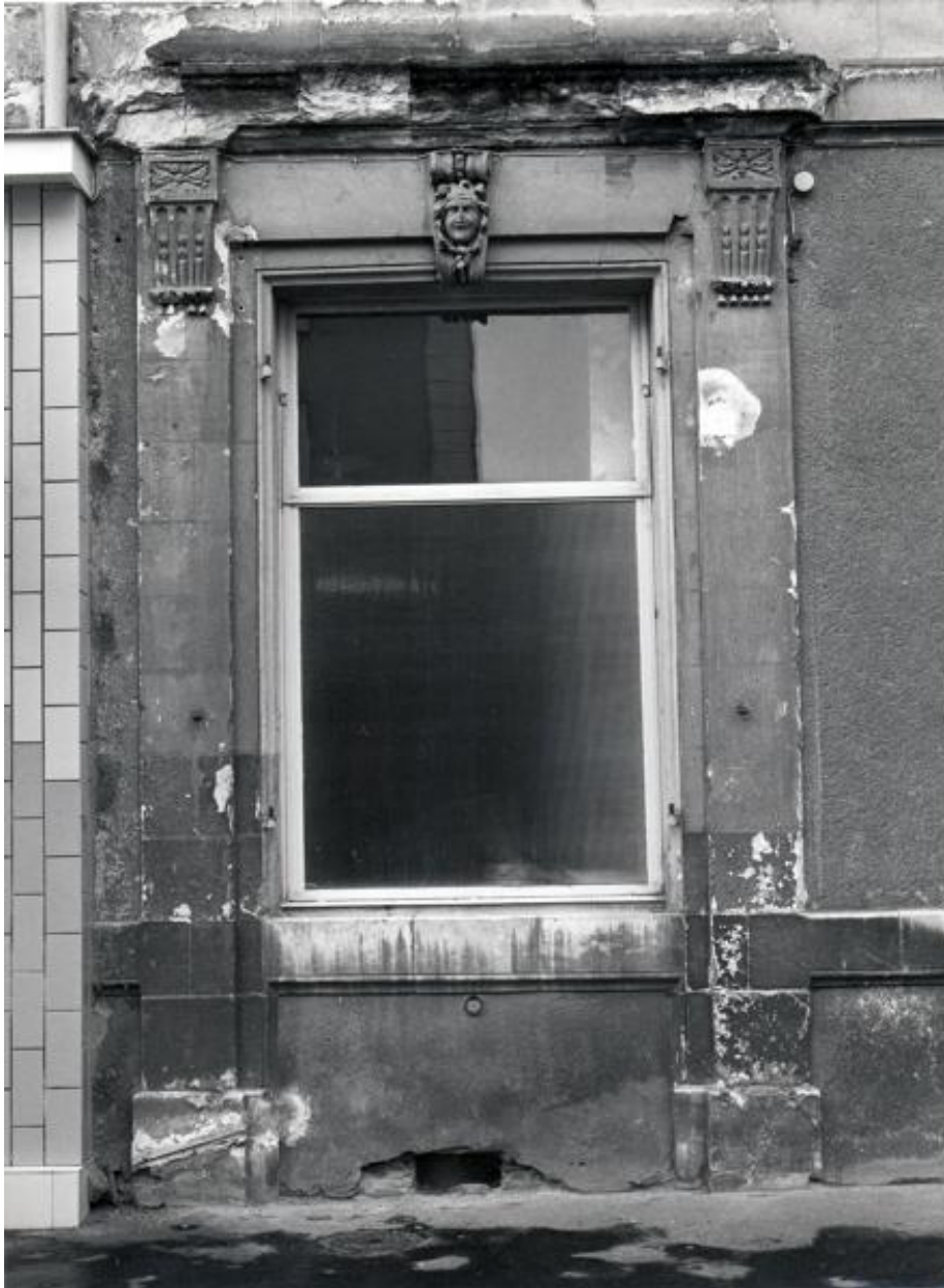
Elévation sur la rue Boisnet : ancienne porte.
