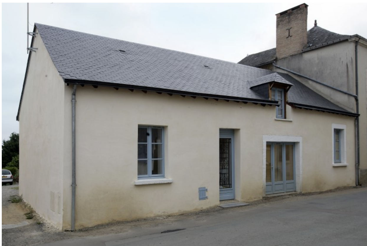
Vue depuis la rue à l'ouest.
