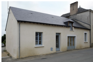
Vue depuis la rue à l'ouest. Phot. François Lasa IVR52_20075302157NUCA
