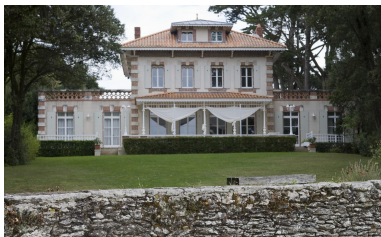
Vue d'ensemble de la villa El Biar, face à la mer. Phot. Denis Pillet IVR52_20094400640NUCA
