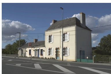
Vue depuis la rue. Le restaurant est à gauche. Phot. François Lasa IVR52_20045303084NUCA
