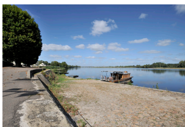
Port du Passeur : cale ouest. Phot. Bruno Rousseau, Phot. Youenn Communeau IVR52_20114902503NUCA
