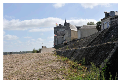
Port du Passeur : talus de la levée de la route de Loire et cales du port. Phot. Bruno Rousseau, Phot. Youenn Communeau IVR52_20114902505NUCA
