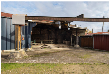
Vue extérieure. Phot. Thierry Seldubuisson IVR52_20247200321NUCA
