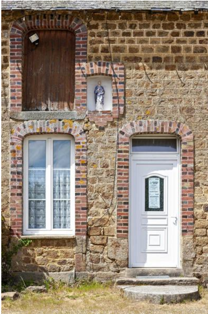
Porte, fenêtre et niche accueillant, encadrées de brique, logis
