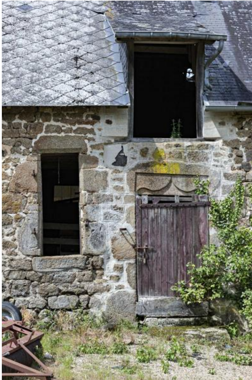
Porte et fenêtre de l'ancien logis, conservé dans l'alignement de bâtiments agricoles reconstruits à la limite entre le XIXe et le XXe siècle
