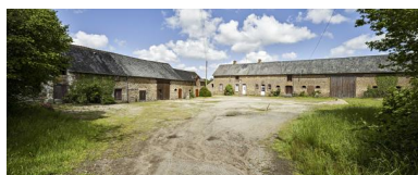
Ferme de la Verdonnerie, vue d'ensemble Phot. Yves Guillotin IVR52_20215300613NUCA
