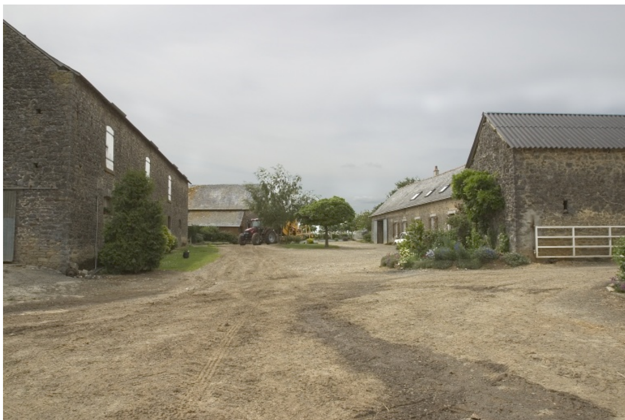
Vue d'ensemble de la ferme sud depuis l'est : l'étable, la remise, le logis, la porcherie.
