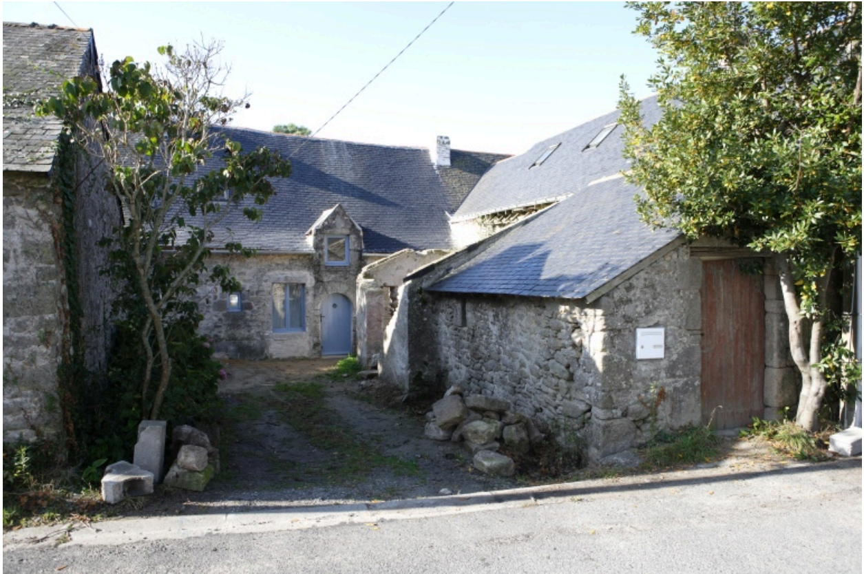
Vue d'ensemble du 2e logement (15 Grande-Rue).
