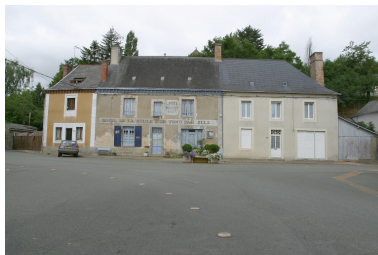
Façade sur la place (bâtiment de droite) Phot. François Lasa IVR52_20035302371NUCA
