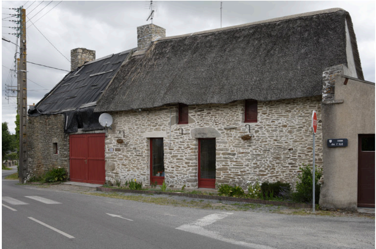
Vue depuis le sud-est.
