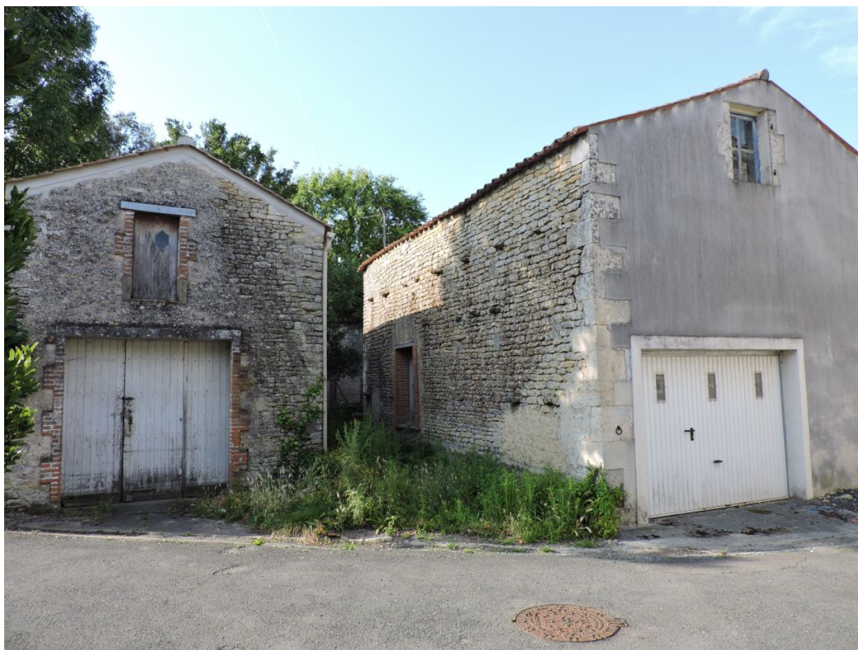
Les remises (et atelier ?) à l'arrière de la maison, vues depuis le nord.
