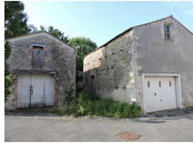
Les remises (et atelier ?) à l'arrière de la maison, vues depuis le nord. Phot. Yannis Suire IVR52_20198502281NUCA
