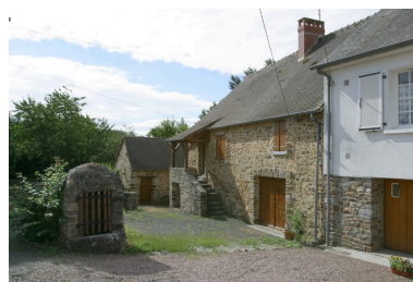
La maison nord et la cour. Au fond, l'ancienne porcherie. Phot. François Lasa IVR52_20035302337NUCA
