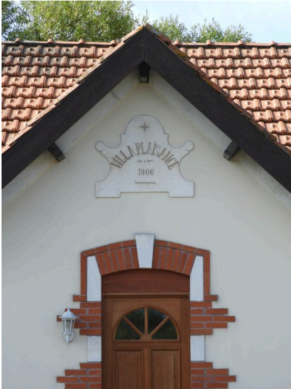
Détail de la façade : partie en pignon, cartouche, décor en brique et en pierre.
