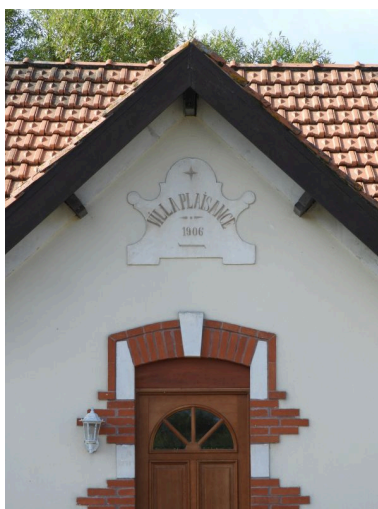
Détail de la façade : partie en pignon, cartouche, décor en brique et en pierre. Phot. Yannis Suire IVR52_20188501244NUCA
