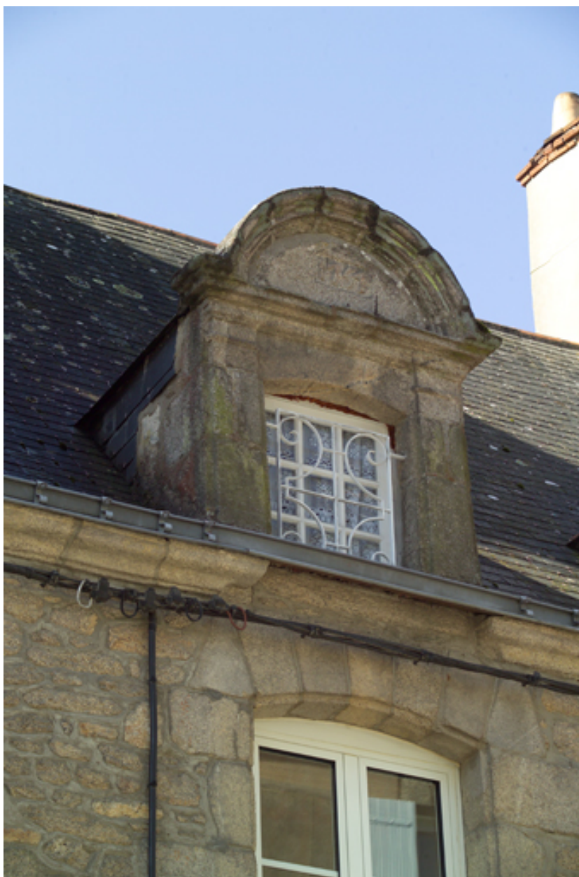
Façade sur rue, détail d'une travée.
