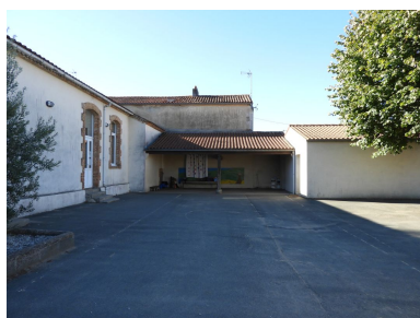
La cour nord-ouest vue depuis le nord, avec le préau au fond et, à gauche, le bâtiment de classes.
