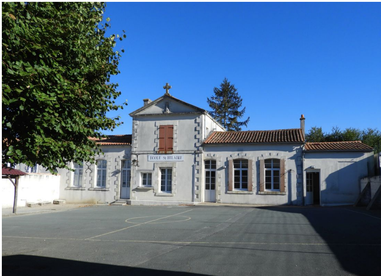
L'école, cour sud-est, vue depuis le sud-est.
