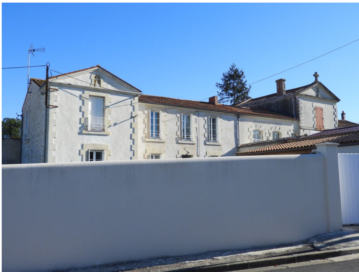
L'aile ouest vue depuis le sud-ouest.
