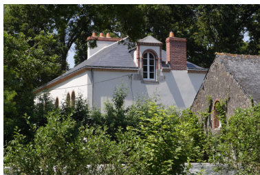
Vue de la lucarne du pignon ouest. Phot. Denis Pillet IVR52_20084401867NUCA
