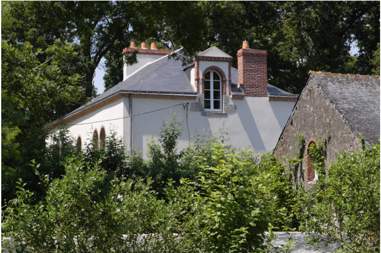
Vue de la lucarne du pignon ouest.
