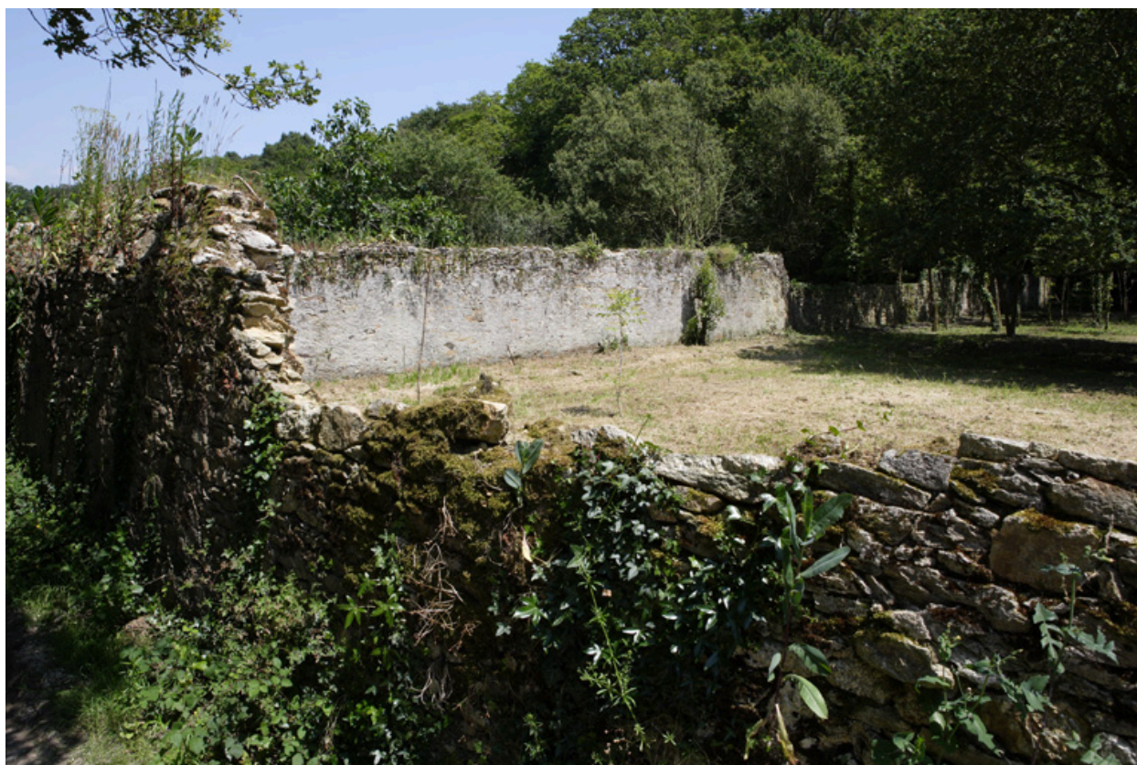
Vue du mur de clôture.
