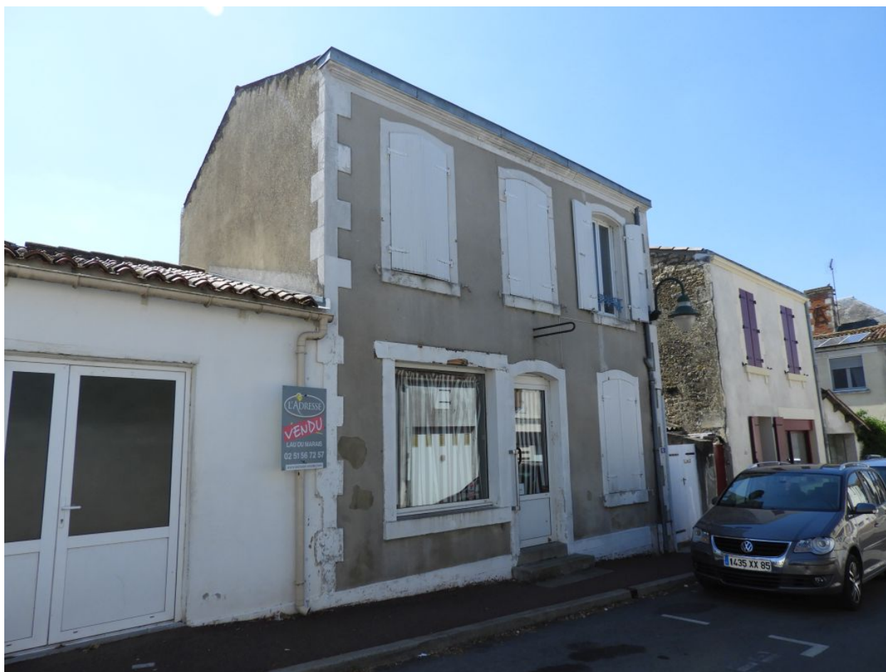
L'ancienne charcuterie vue depuis le nord-est.
