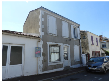
L'ancienne charcuterie vue depuis le nord-est.
