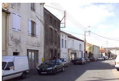
La rue Pitre-Chevalier vue vers l'aval, les maison n° 13, n° 15, n° 17. Phot. Denis Pillet IVR52_20044401915NUCA
