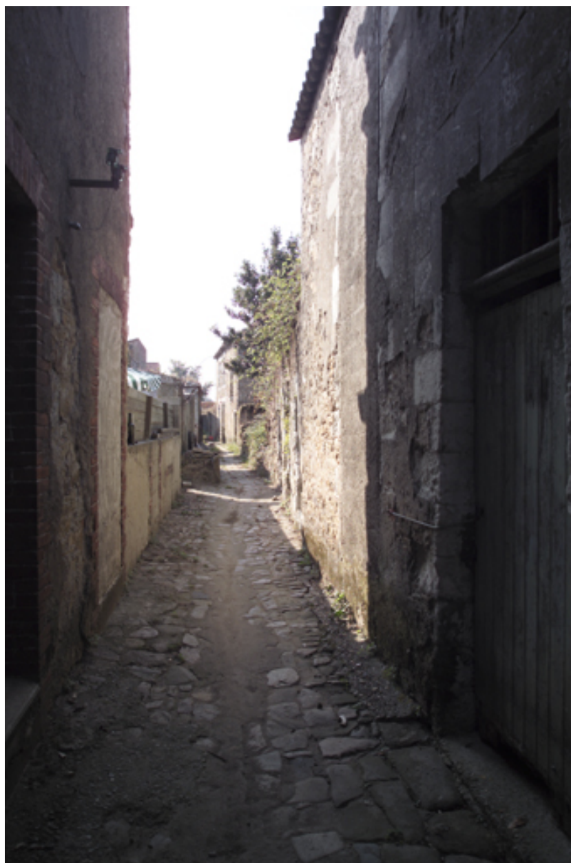
Vue de l'allée commune au n° 15 et n° 17 depuis l'entrée.
