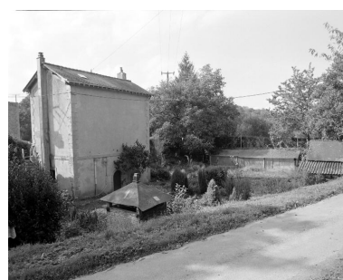
La maison éclésièr et son jardin vus de l'est. A gauche, les latrines. Phot. François Lasa IVR52_20015300472X
