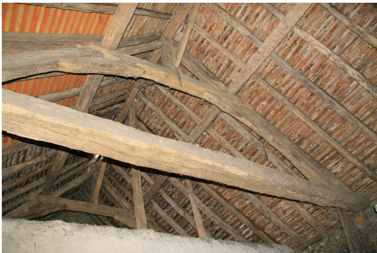
La charpente de la maison.
