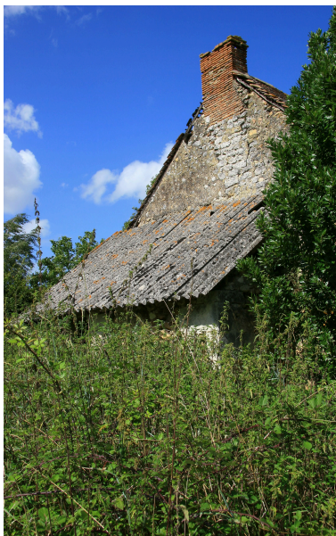
La maison du XVII e siècle : pignon avec four à pain couvert d'un appentis. Phot. Jean-Baptiste Darrasse IVR52_20087201756NUCA
