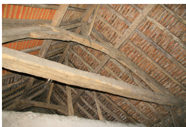
La charpente de la maison. Phot. Jean-Baptiste Darrasse IVR52_20087201752NUCA
