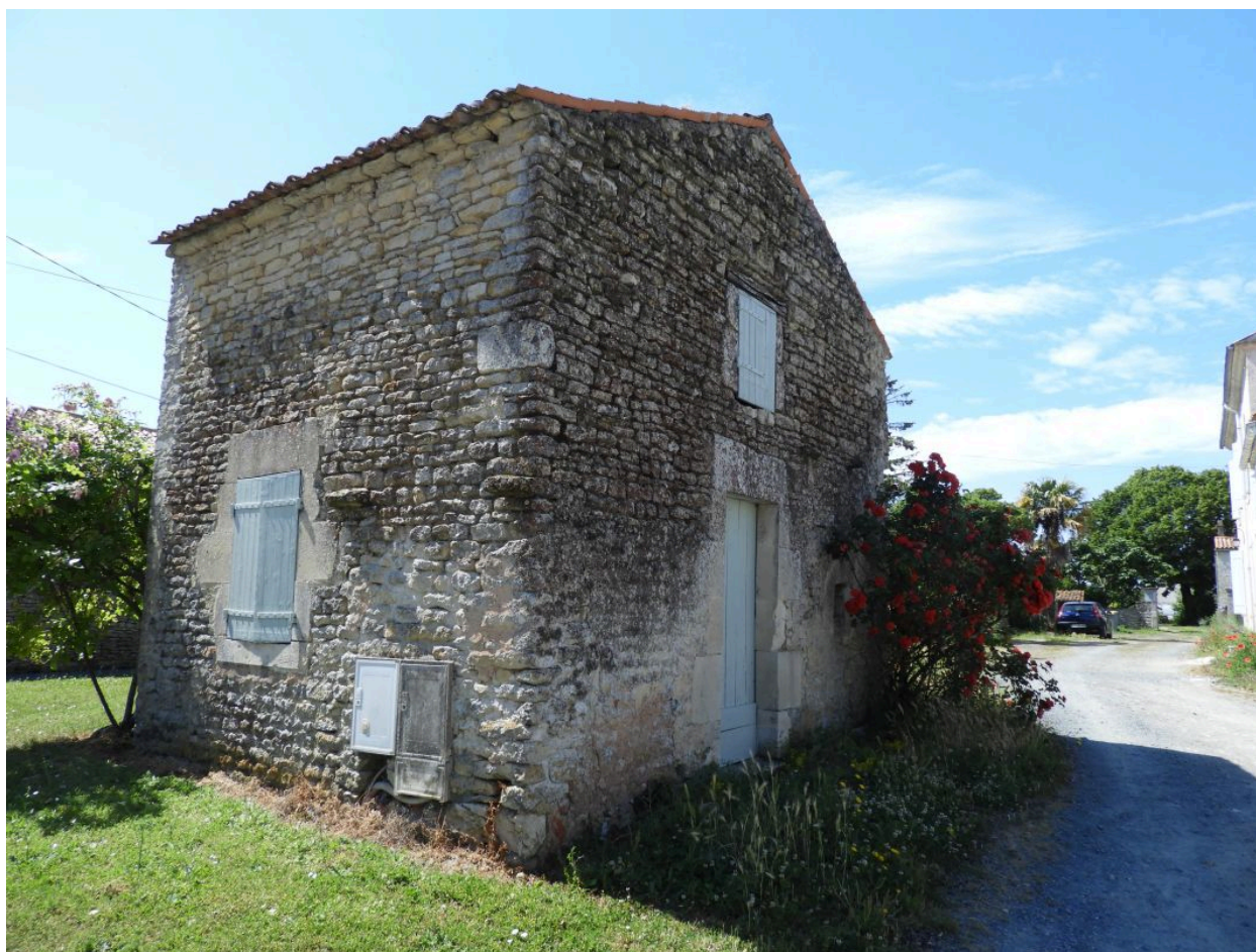
La remise vue depuis le nord.
